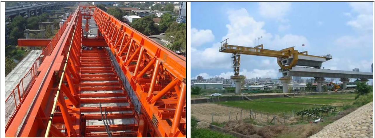
รูปที่ 1 Launching Girder
