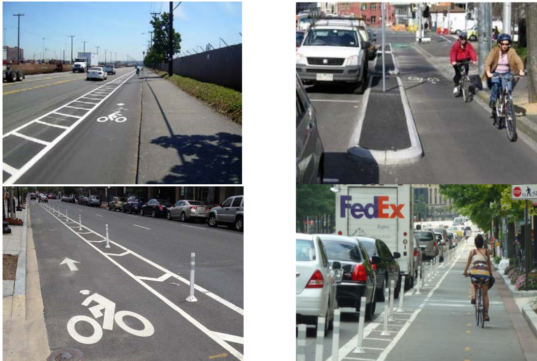
รูปที่ 18 ทางจักรยานแบบจัดทำพื้นที่กันชน (Buffer)
