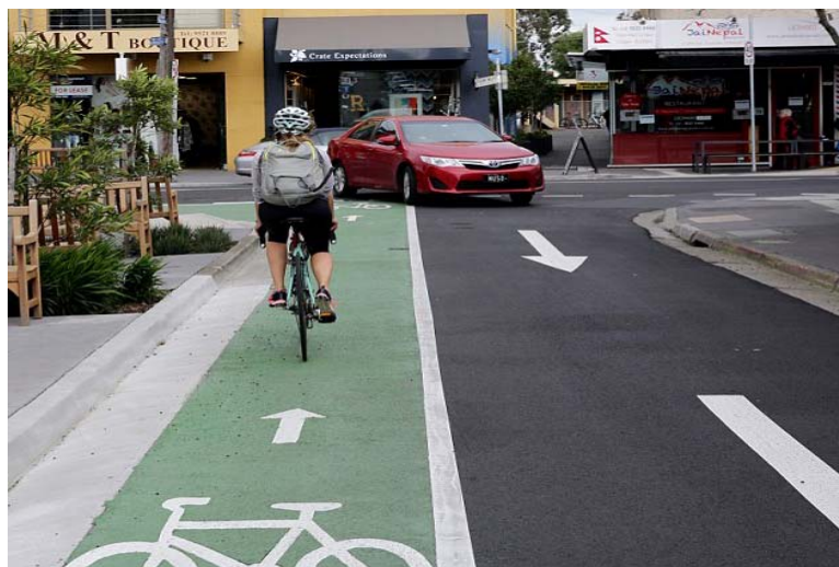
รูปที่ 26 การใช้สีบนพื้นผิวทางจักรยาน
