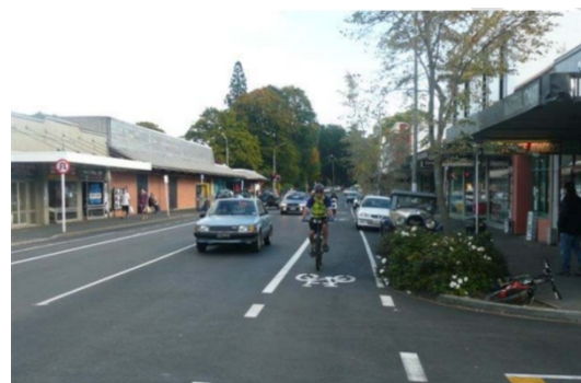
รูปที่ 16 ทางจักรยานแบบช่องจราจรจักรยาน (Bicycle Lane) กรณีห้ามจอดรถ (ซ้าย) และจอดรถได้ (ขวา)
