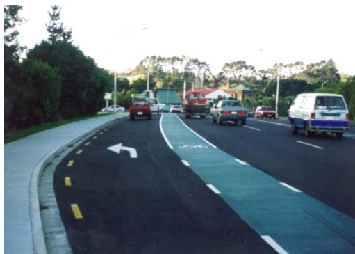
รูปที่ 20 กรณีที่ช่องจราจรจักรยานอยู่ระหว่างช่องจราจรทั้งด้านซ้ายและด้านขวา
