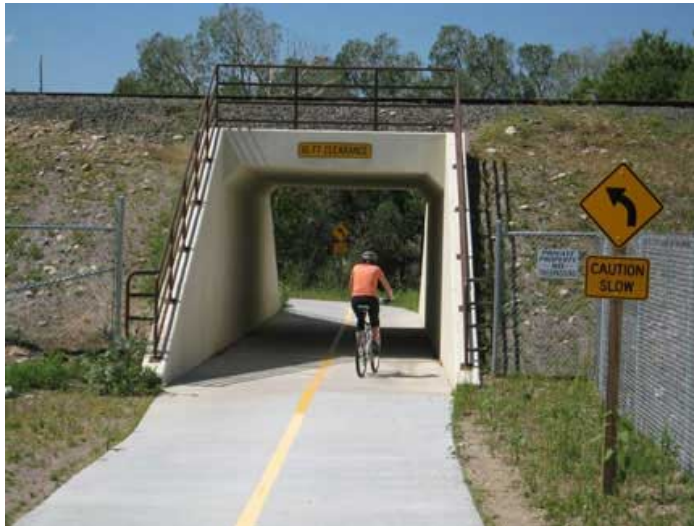
รูปที่ 13 ความสูงช่องลอด (Vertical Clearance)
