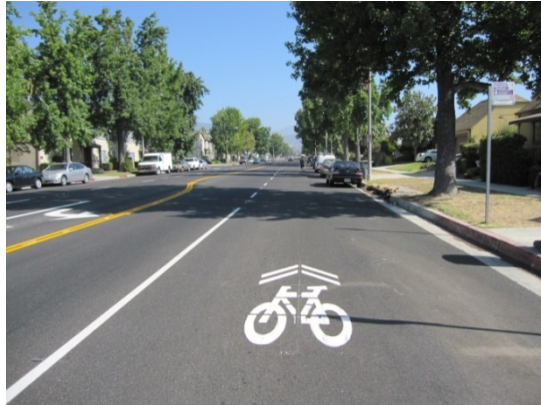
รูปที่ 17 ทางจักรยานแบบทำช่องจราจรด้านริมให้กว้างกว่าปกติ (wide curb lane)
