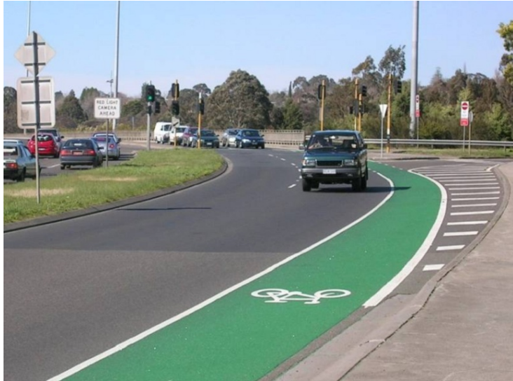
รูปที่ 23 การใช้สีบนพื้นผิวทางจักรยาน
