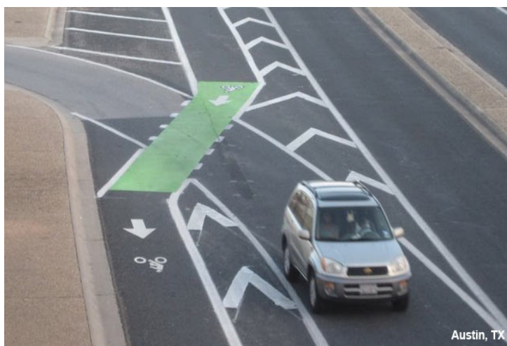
รูปที่ 24 การใช้สีบนพื้นผิวทางจักรยาน
