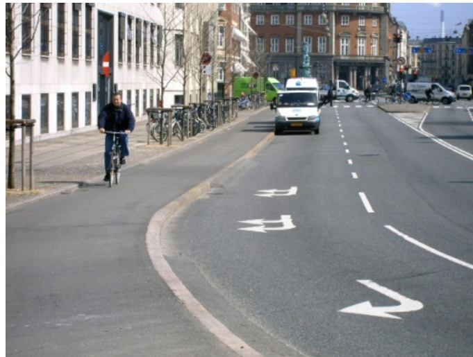
รูปที่ 6 การใช้ขอบคั่นหินจัดพื้นที่เฉพาะสำหรับจักรยาน (Over the Bars in Wisconsin, 2010)
