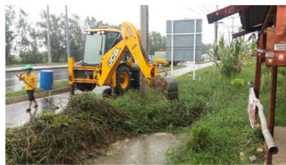
เจ้าหน้าที่ทำความสะอาดและเปิดทางระบายน้ำ ทล.1
