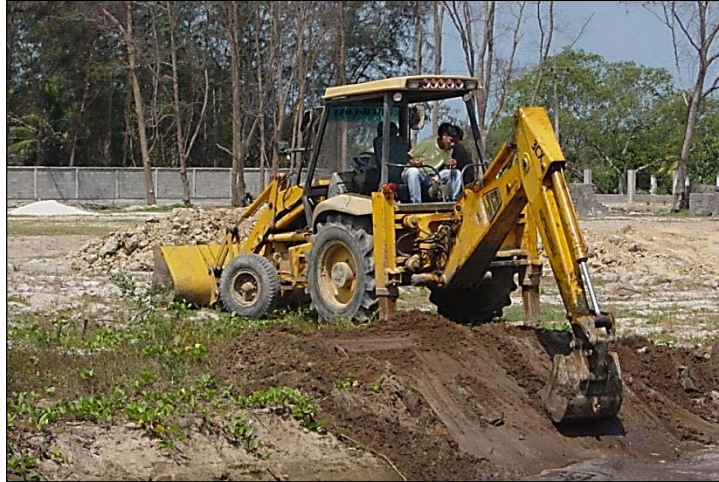
รูปที่ 7.32 การแต่งขอบสระน้ำ โดยจอดเครื่องจักรในแนวตั้งฉากกับพื้นที่ทำงาน
