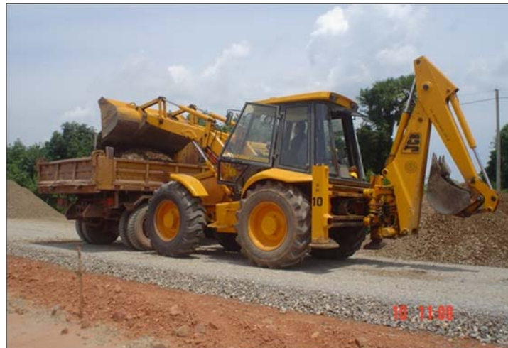
รูปที่ 7.26 การตักวัสดุใส่รถบรรทุก
