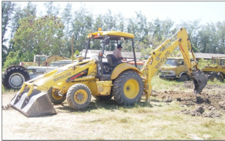
รูปที่ 7.11 การจอดเครื่องจักรเพื่อใช้ชุดชุดหลัง สำหรับพื้นที่ดินอ่อน
