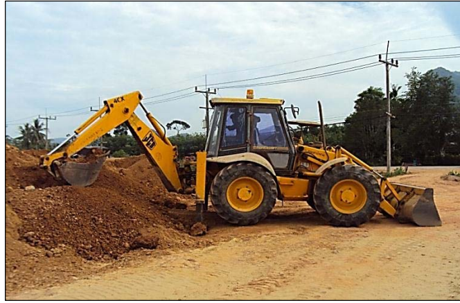
รูปที่ 7.25 การกระจายกองวัสดุโดยใช้ปู้งกี้ด้านหลัง
