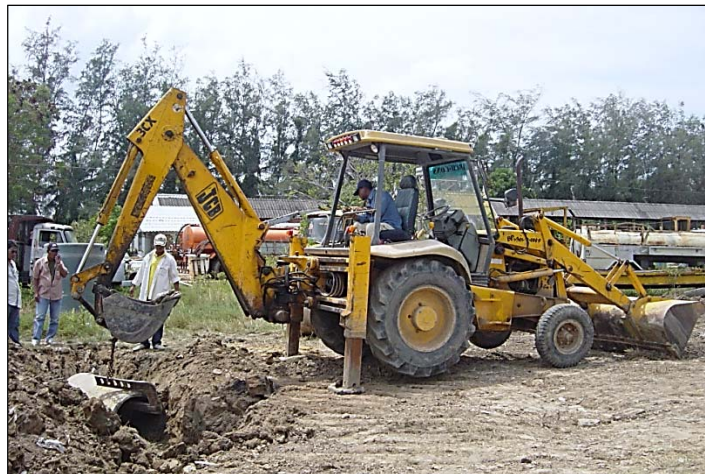
รูปที่ 7.31 การขุดแต่งร่องน้ำโดยใช้ปู้งกีหลัง แล้วใช้ปู้งกีหน้าตัดกวดใส่รถบรรทุก
