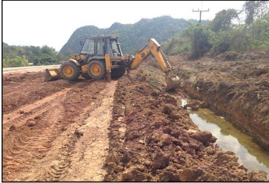
รูปที่ 3.6 การใช้รถตักหน้า-ขุดหลังขุดร่องน้ำใหม่
