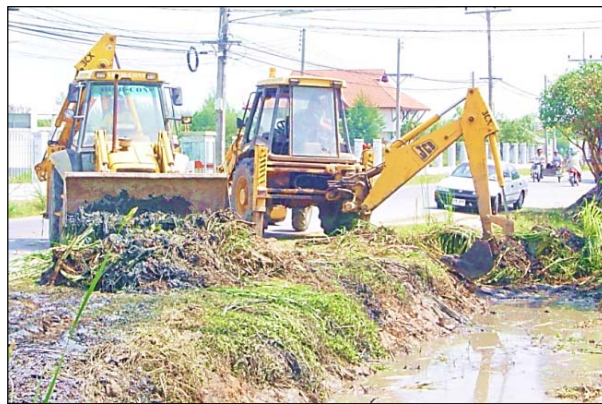
รูปที่ 2.7 การขุดแต่งร่องน้ำโดยใช้ปุ๋ยก็หลัง แล้วใช้ปุ๋ยก็หน้าตัดวัสดุใส่รถบรรทุก
