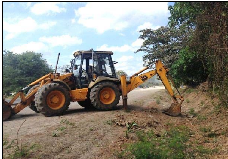
รูปที่ 3.9 การใช้รถตักหน้า-ขุดหลังแต่งลาดคันทาง
