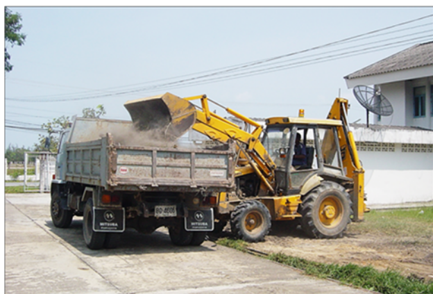
รูปที่ 2.5 การตักวัสดุใส่รถบรรทุก
