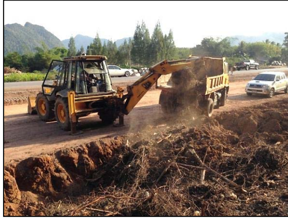
รูปที่ 3.4 การใช้รถตักหน้า-ชุดหลัง ตักวัสดุไม่พึงประสงค์เพื่อนำไปทิ้ง
