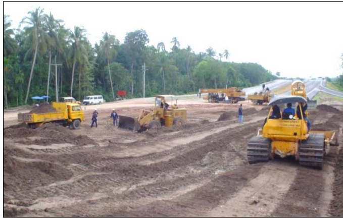
รูปที่ 1.1 การใช้เครื่องจักรกลในพื้นที่งานก่อสร้างทาง
