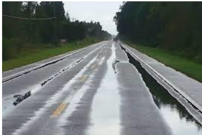
รูปที่ 1 ปัญหาการเกิดร่องล้อบนทางหลวง
