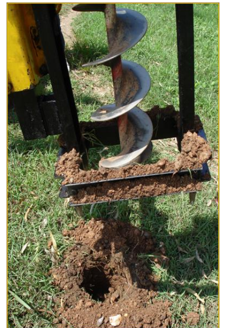
รูปการเจาะหลุม/ติดตั้งป้ายจราจรบนทางหลวงหมายเลข 101 ในพื้นที่รับผิดชอบแขวงการทางแพร์
