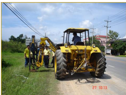
รูปการเจาะหลุม/ติดตั้งป้ายจราจรบนทางหลวงหมายเลข 101 ในพื้นที่รับผิดชอบแขวงการทางแพร์
