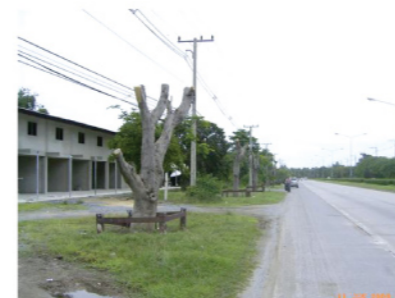
ภาพแสดงการตัดแต่งกิ่งต้นไม้แนวสายไฟฟ้า ที่เป็นไปตามหลักเกณฑ์
