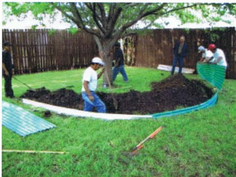
รูปที่ 1.11 การติดตั้งแผ่นกันรากที่ทำจากสังกะสี
