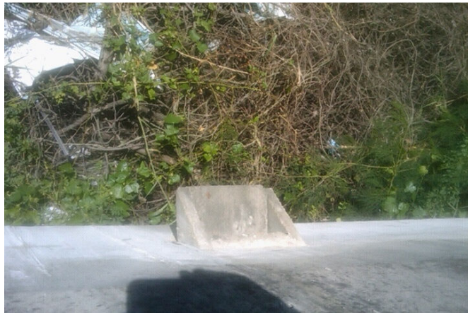
รูปที่ 1.11 แสดง Mortar Pipe ในสะพานประเภท Plank Beam
