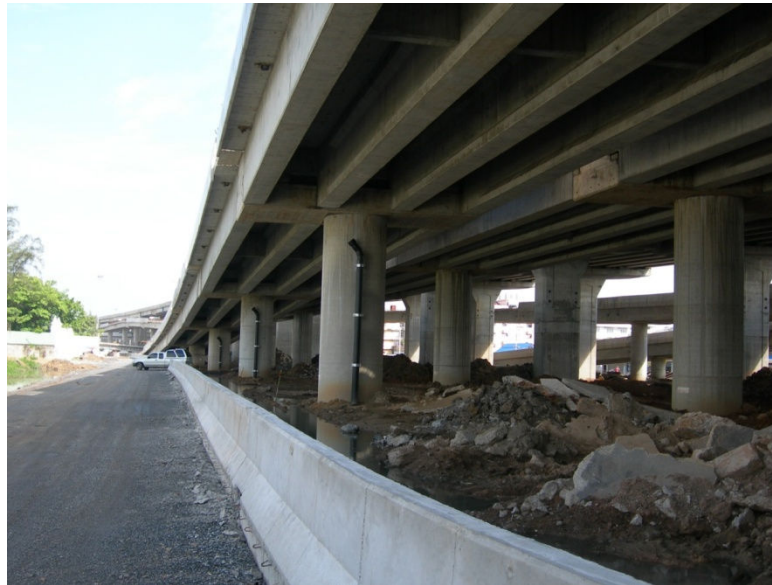
รูปที่ 1.16 ระหว่างการติดตั้ง ท่อ Drain Pipe ประเภท HDPE ในสะพานประเภท I-Girders
