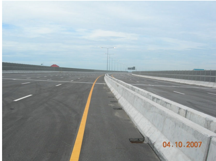
รูปที่ 1.20 ลักษณะของ Grating Inlet ที่ใช้ระบายน้ำบนสะพานประเภท I-Girders
