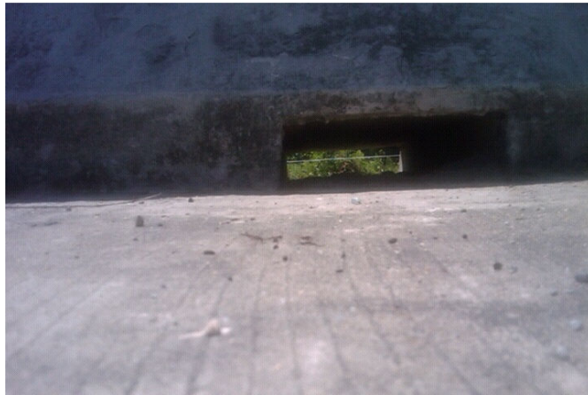
รูปที่ 1.10 แสดง Mortar Pipe ในสะพานประเภท Plank Beam
