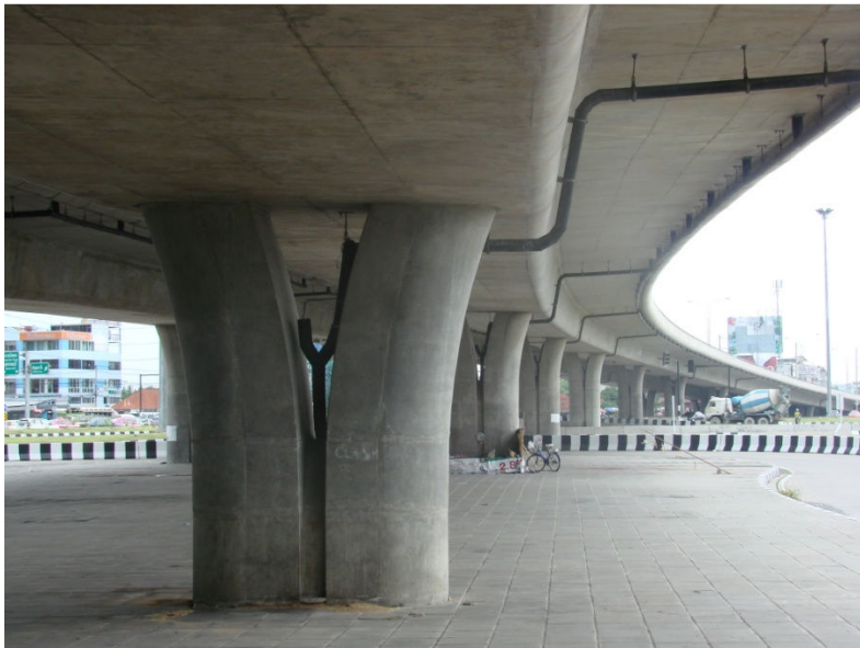
รูปที่ 1.25 ท่อ HDPE เพื่อใช้สำหรับระบบระบายน้ำจากบนสะพานในสะพานประเภท Box Girders
