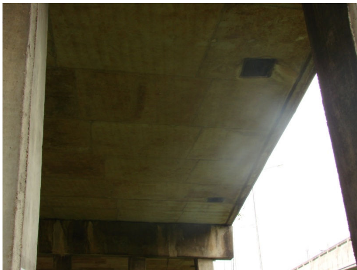
รูปที่ 1.8 แสดง Mortar Pipe ในสะพานประเภท Slab Type
