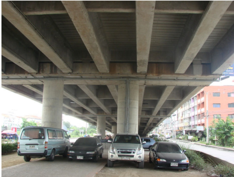
รูปที่ 1.17 ท่อ Drain Pipe ประเภท HDPE ในสะพานประเภท I-Girders
