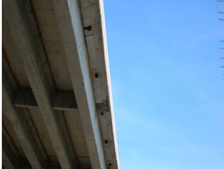
รูปที่ 1.15 ท่อ HDPE เพื่อใช้ระบบน้ำจากบนสะพานในสะพานประเภท I-Girders
