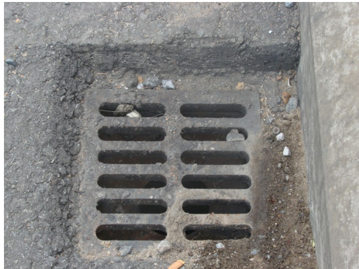
รูปที่ 1.21 ลักษณะของ Grating Inlet ที่ใช้ระบายน้ำบนสะพานประเภท I-Girders
