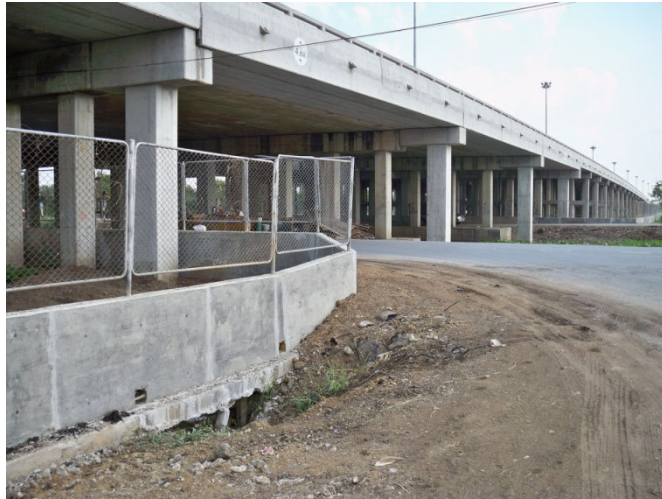
รูปที่ 1.9 แสดง Mortar Pipe ในสะพานประเภท Plank Beam
