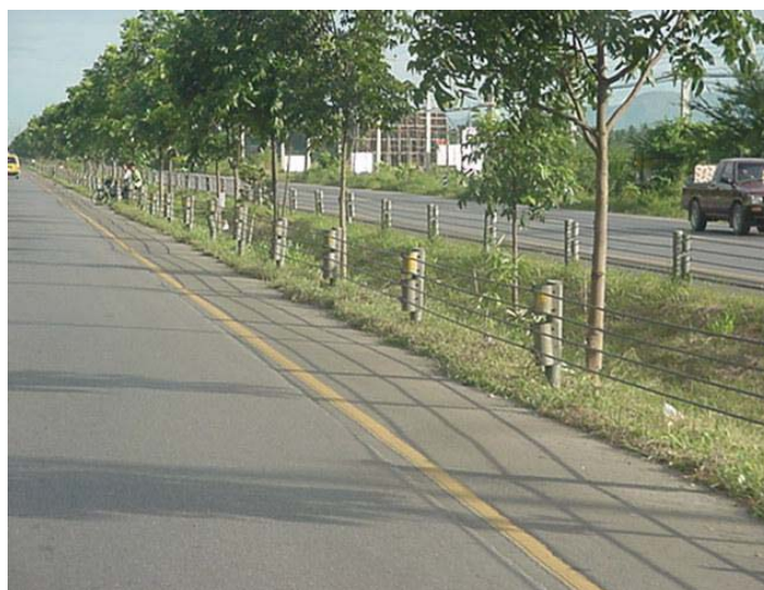
รูปที่ 18 ราวกันของเกาะกลางแบบลวดเคเบิล (Guard Cable)
