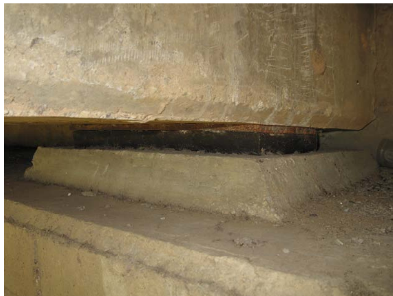
รูปที่ 6-20 Neoprene Bearing
