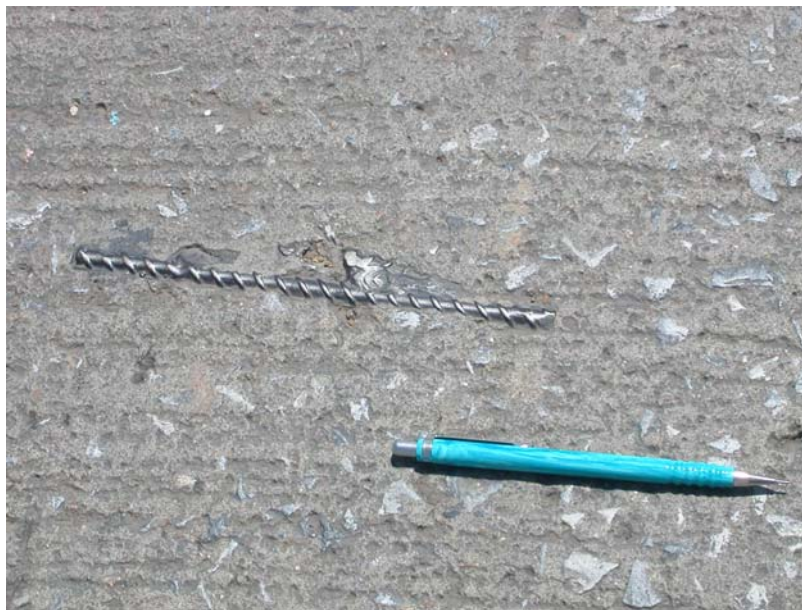
รูปที่ 6-1 การขำรดของพื้นสะพานคอนกรีต แสดงให้เห็นว่า เหล็กเสริมหลักมีทิศทางตั้งฉากกับทิศทางการจราจร
