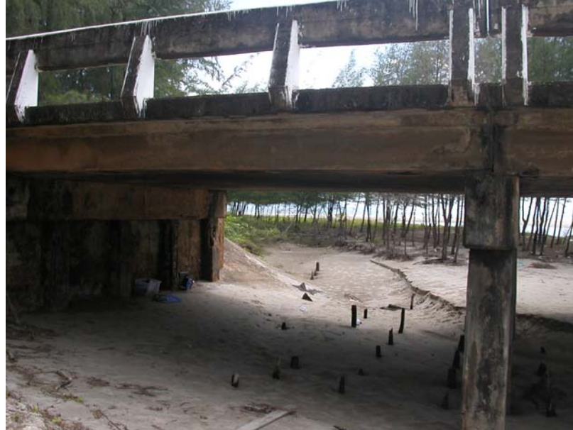
รูปที่ 2-28 Concrete Abutment
