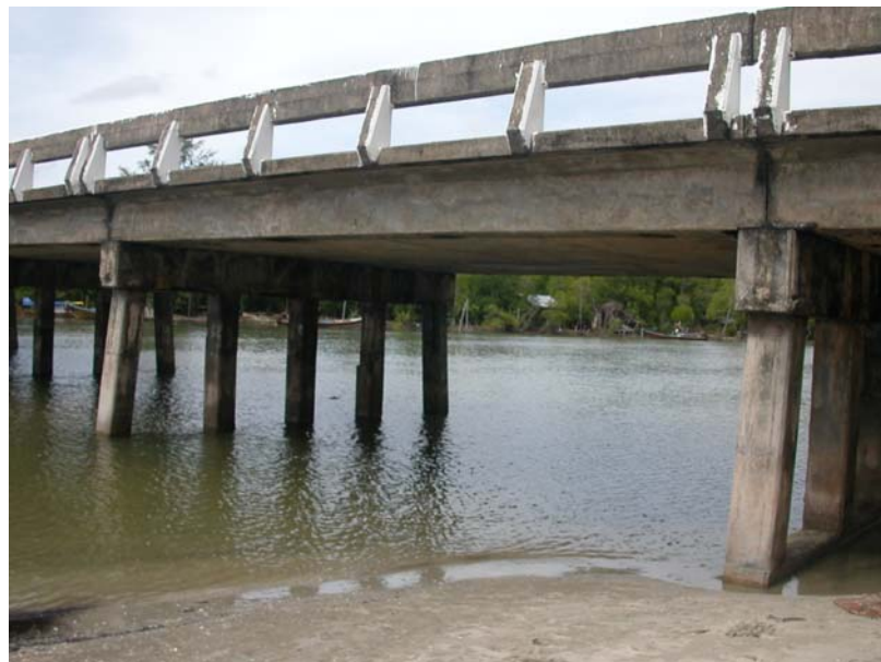
รูปที่ 2-29 Concrete Pier
