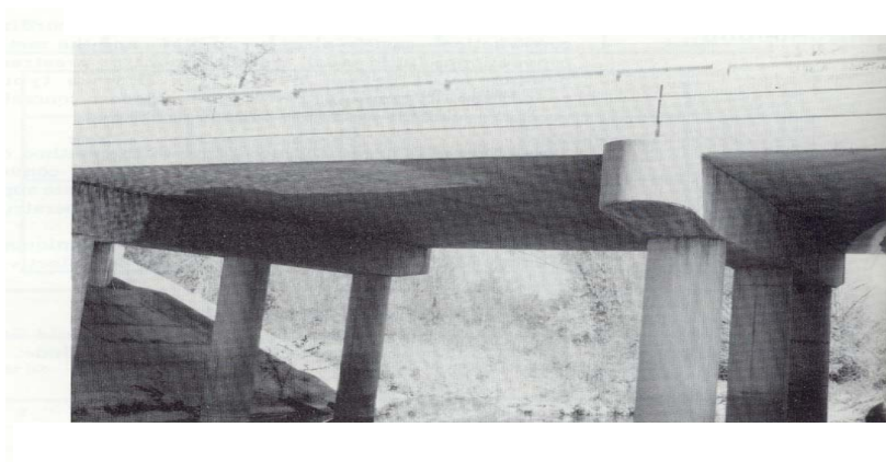
รูปที่ 6-10 สะพานแบบพื้นคอนกรีตหลายช่วง (Multi Span Slab Bridge)
