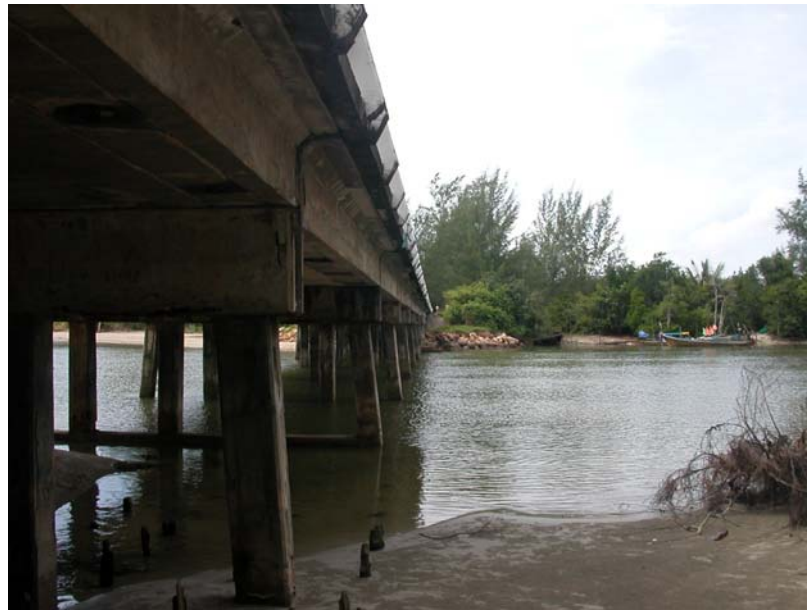
รูปที่ 2-33 การถูกกัดเซาะของท้องน้ำ
