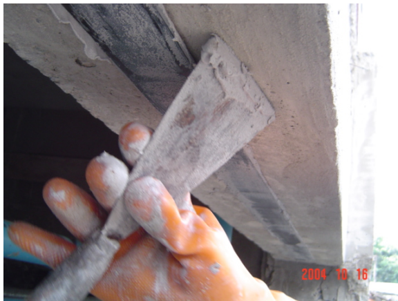
ฉ. การทำความสะอาดผิวงานหลังจากการติดตั้งแผ่น FRP
