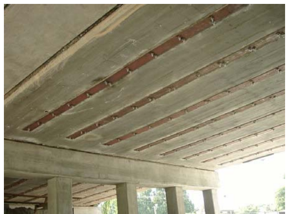
ข. การติดตั้งแผ่นเหล็กที่เสร็จสมบูรณ์
