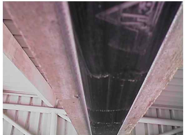
ฉ. การทำความสะอาดผิวงานหลังจากการติดตั้งแผ่น FRP
