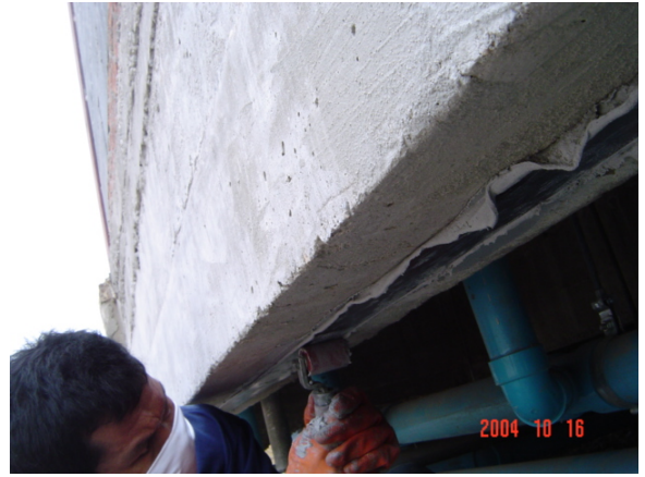
จ. การรีดไล์ฟองอากาศออกหลังจากการติดตั้งแผ่น FRP
