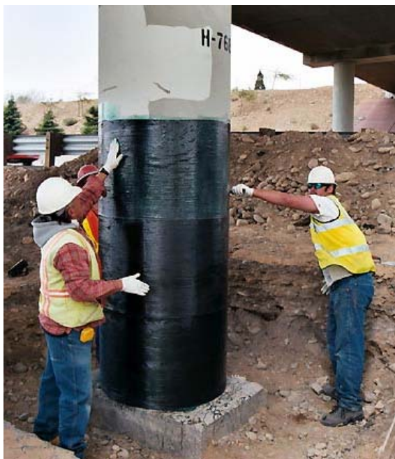
ข (การพัน Carbon fiber sheet โดยใช้คน
