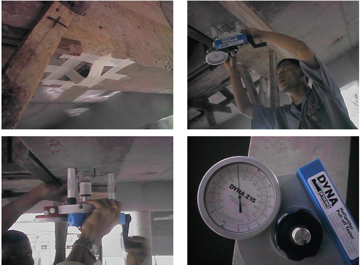
รูปที่ 8-8 การทดสอบ Pull-off Test(ต่อ)
