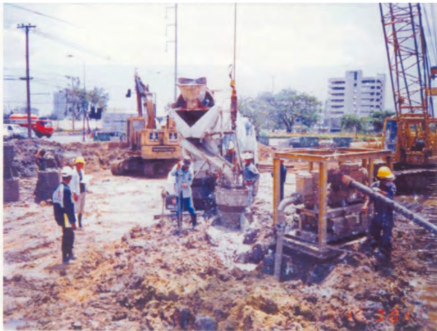
ขณะทำการเทคอนกรีต น้ำยา Bentonite จะล้นออกมา และใช้ Pump ดูดกลับมา Recycle ใช้ได้ใหม่
