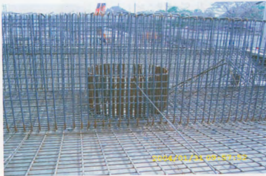
รูปที่ 10 การเสริมเหล็กคานหัวเสา (Crosshead)
