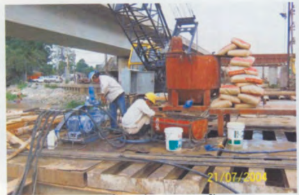
การติดตั้งเครื่องมืออัดน้ำปูน
