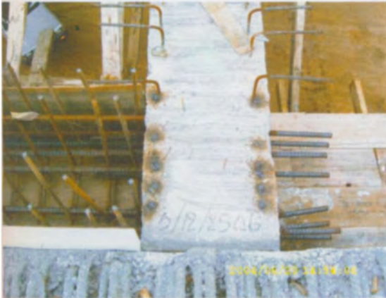
ติดตั้งโฟมกันระหว่าง End Diaphragm กับ Crosshead
