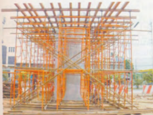
ติดตั้งนั่งร้านรองรับห้องแบบ
