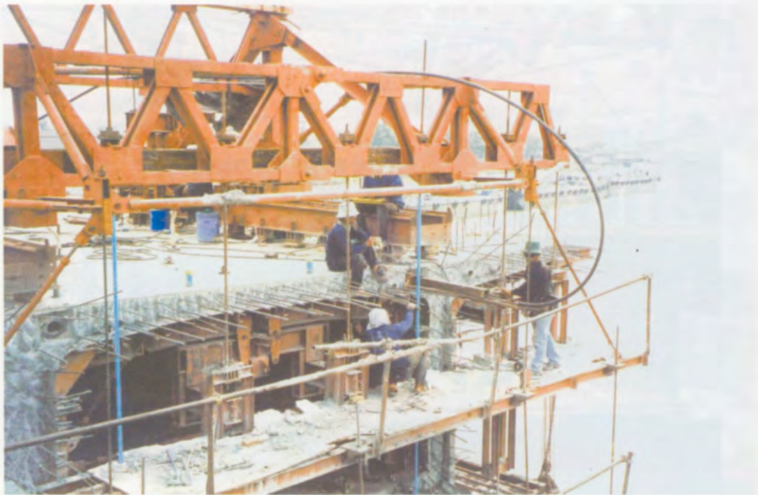
ร้อยลวดอัดแรงใน Longitudinal Tendon
