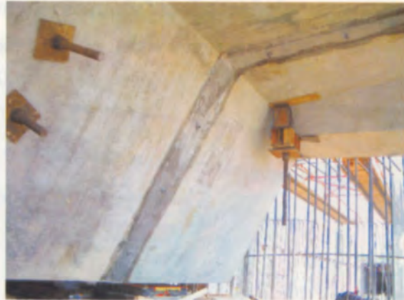
แสดง Closure Joint ด้านข้าง
