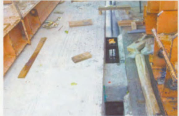
Concrete Block ใน Closure Joint
