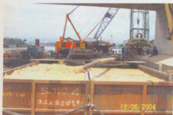
ถังพักตะกอนดิน (Slush tank) จากการขุดเจาะ โดยวิธี Reverse Circulation
