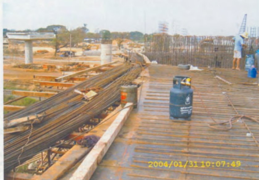
รูปที่ 8 การประกอบแบบพื้นล่าง
