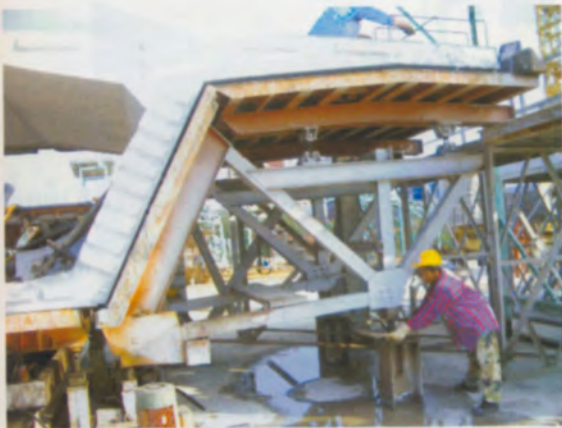
ปรับ External Form ลงเพื่อเลื่อน New Segment ออกมา
