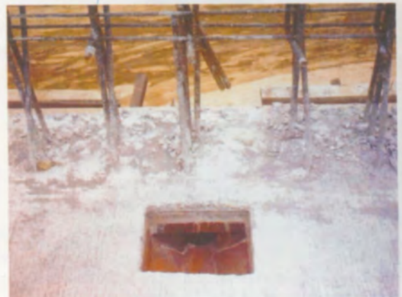
แต่งคอนกรีตรอบตำแหน่งท่อระบายน้ำ และนำแบบออก
