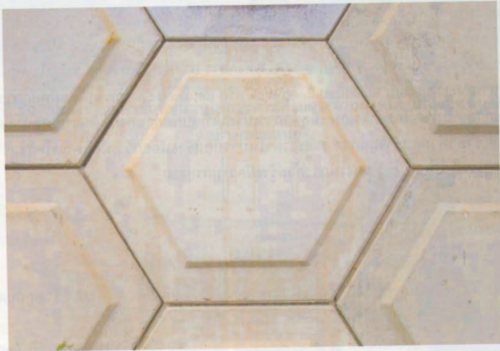
รูปที่ 1 แผ่นผนังคอนกรีตกำแพงกันดิน (Precast Facing Panels) แบบหกเหลี่ยม
