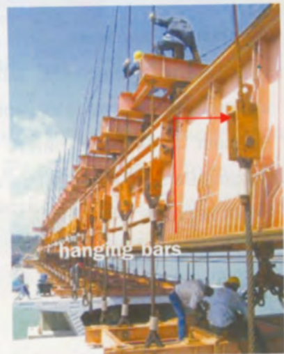
ติดตั้ง Segment ครบทั้ง Span
