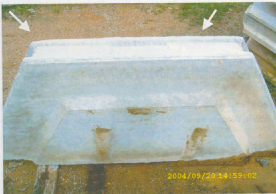
รูปที่ 30 การติดตั้งแผ่นรองรอยต่อ (Polyethylene Pad) ระหว่างแผ่นผนังคอนกรีตชั้นล่างและชั้นบน
