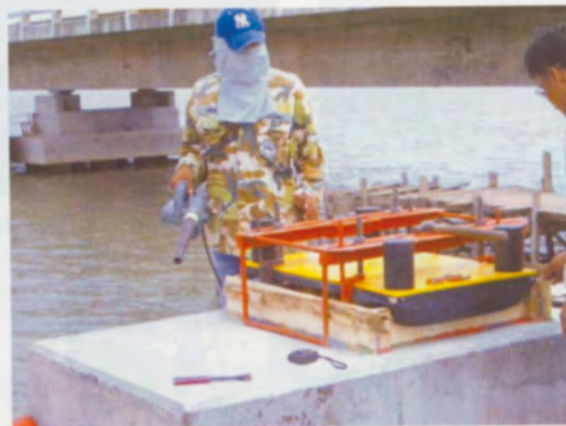
ติดตั้ง formwork
