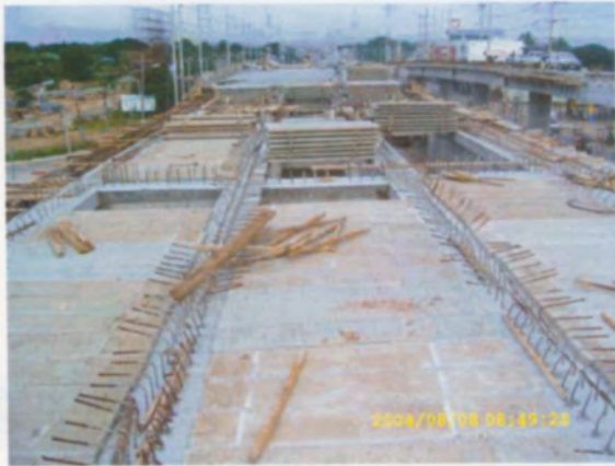
ปูแบบ Precast Concrete Slab
