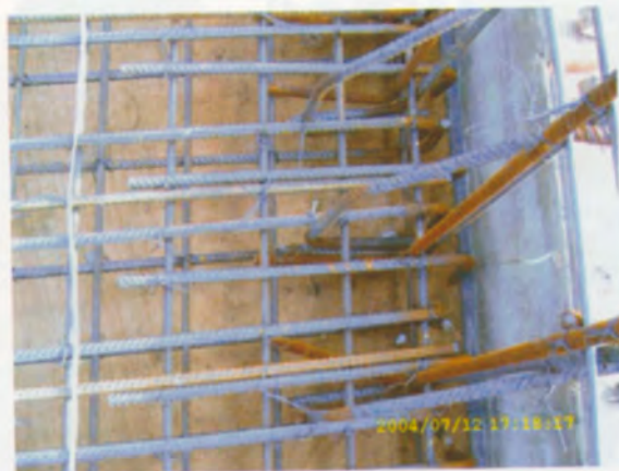
เหล็กเสริมขอบทางและราวสะพาน
