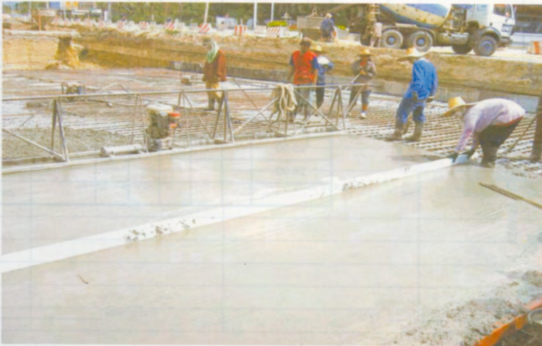
การเทคอนกรีต Base Slab
