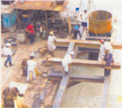
ปักปลอกเหล็กเส้าเข็มลงในคอกซึ่งกำหนดตำแหน่งไว้ตามแบบ
