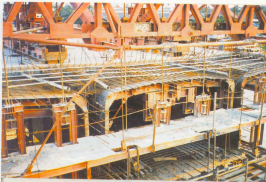
การติดตั้ง Transverse Tendon ใน Top Slab ของ Segment
