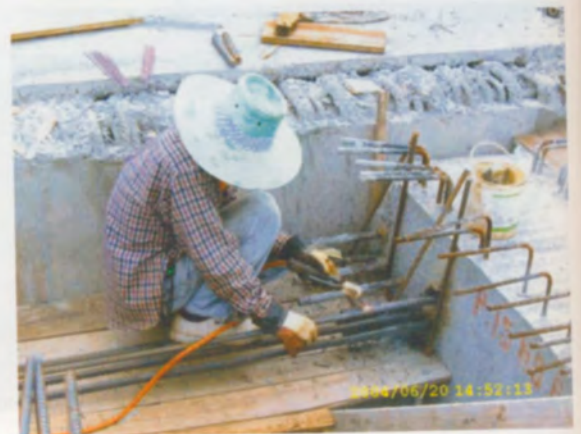
เสริมเหล็ก End Diaphragm
