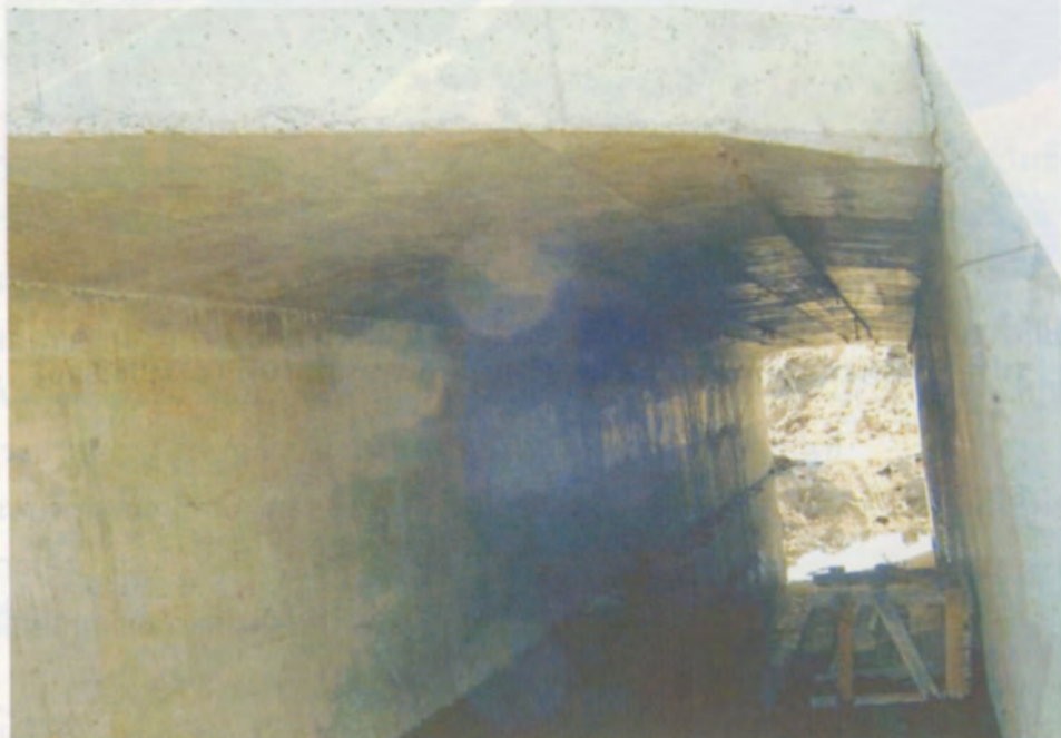
รูปที่ 3 แสดงผนังด้านในของท่อเหลี่ยมคอนกรีตเสริมเหล็กแบบหล่อในที่
