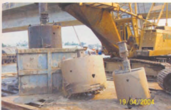
ถังขุด (Bucket) สำหรับเจาะดินชั้นทรายได้น้ำ
