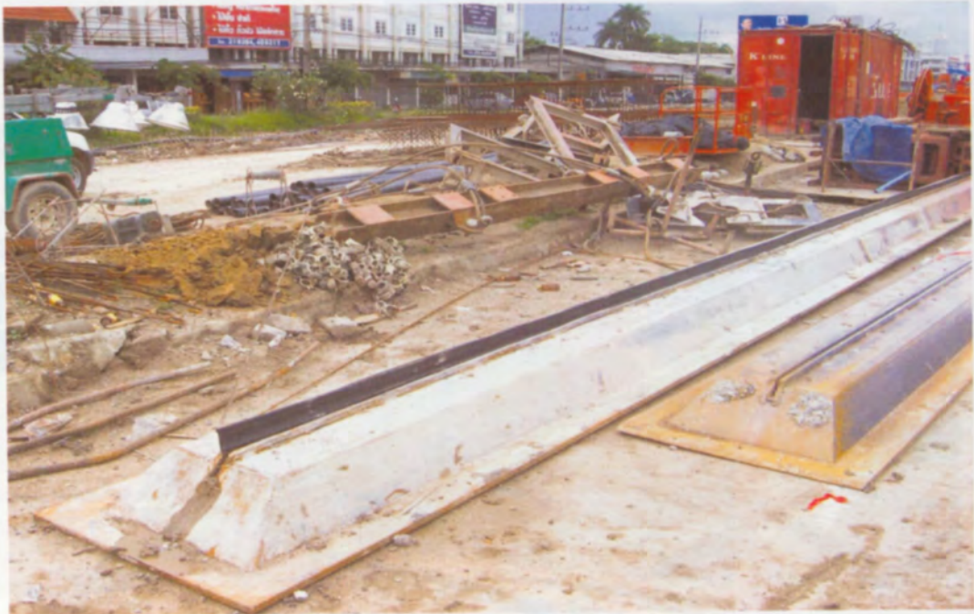
รูปที่ 9 แบบหล่อปิดปลายผนังพืด (Stop End Plates)
