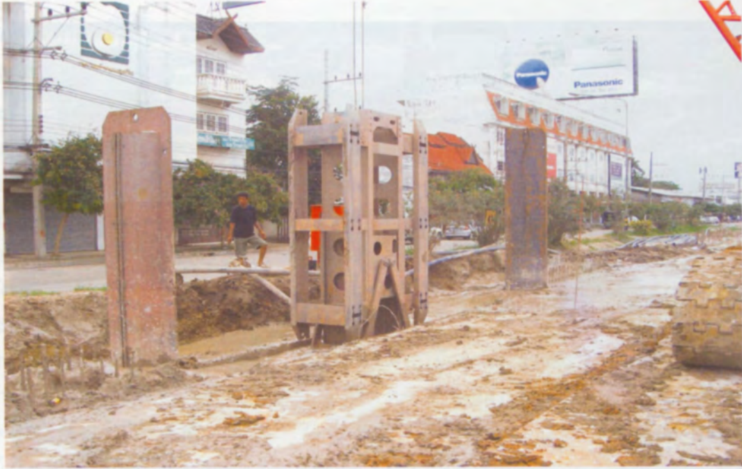
การขุด Diaphragm Wall
