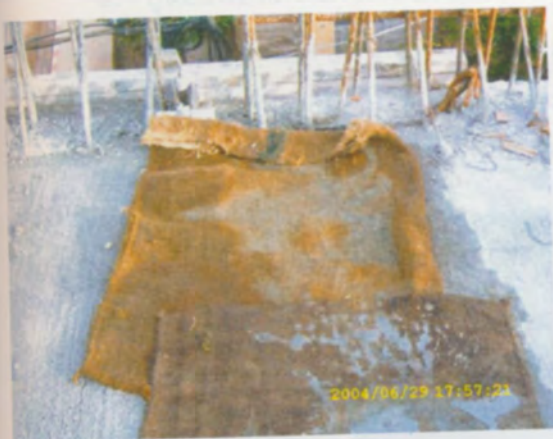
การบ่มคอนกรีตที่รอยต่อพื้นสะพาน
