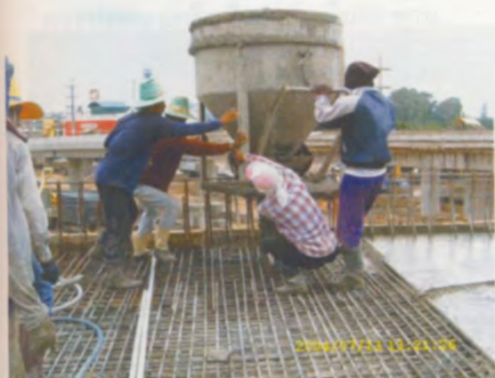
การเทคอนกรีตด้วย Bucket
