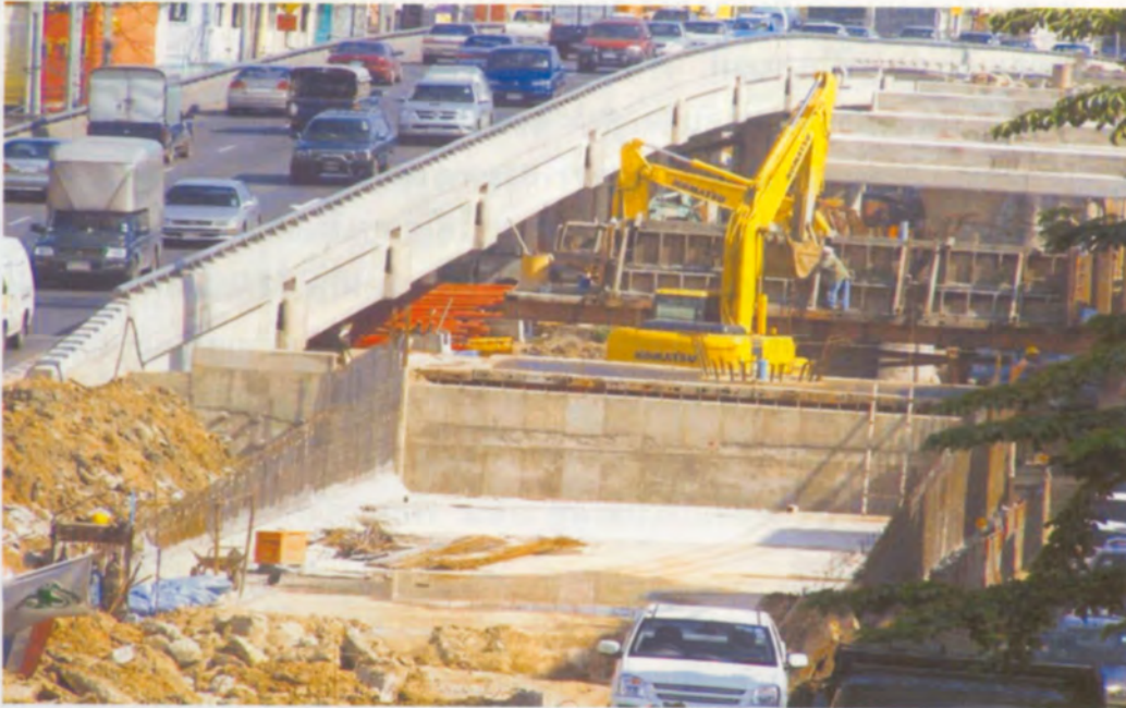
รูปที่ 6 Bearing Unit with Retaining Wall ที่กำลังก่อสร้างในเขตที่มีการจราจรหนาแน่น และเขตทางจำกัด
