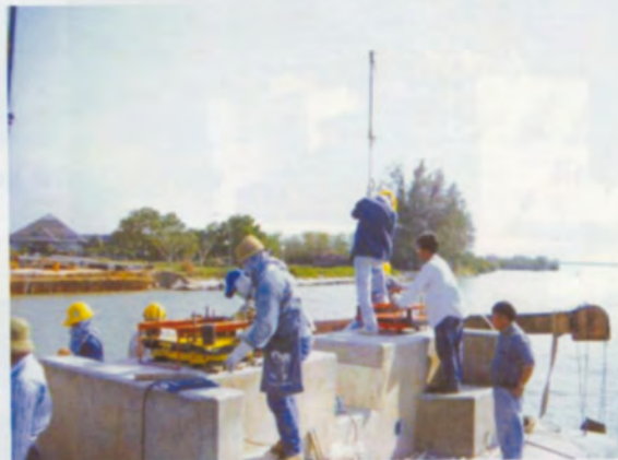
จัดตำแหน่งแนว (alignment) และระดับของ Pot Bearing
