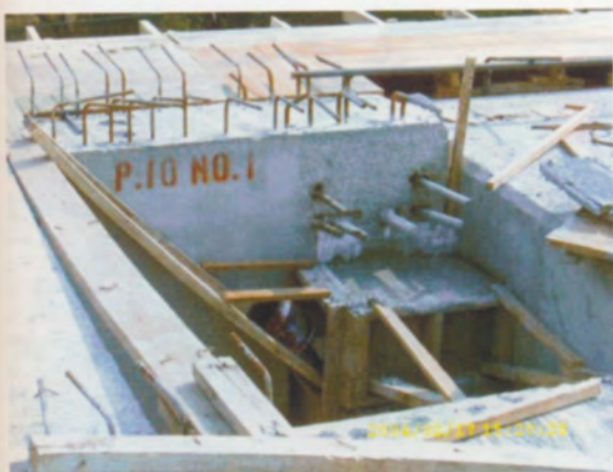
เทค่อนกรีต Seismic Buffer ที่ริมคาน
