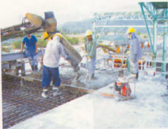
เท Deck Slab
