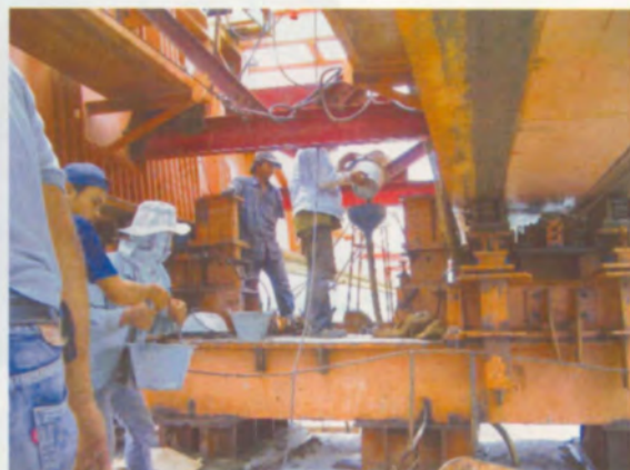
Grouting Top Plate ของ Pot Bearing ด้วย High Strength Grout
