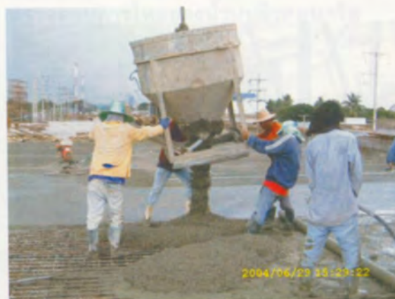
การเทคอนกรีตด้วย Bucket
