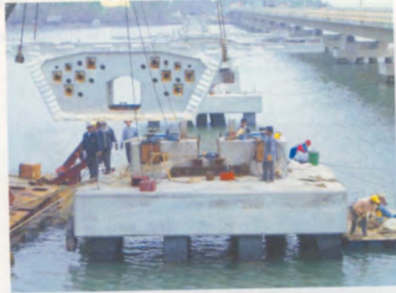
ยก Pier Segment วางบน Pier Column
