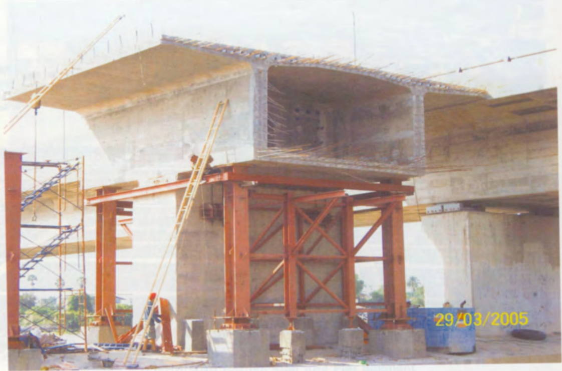
Pier Segment ที่หล่อคอนกรีตแล้วเสร็จ ยึดติดไว้กับนั่งร้านชั่วคราวด้วย Tie Down Bars
