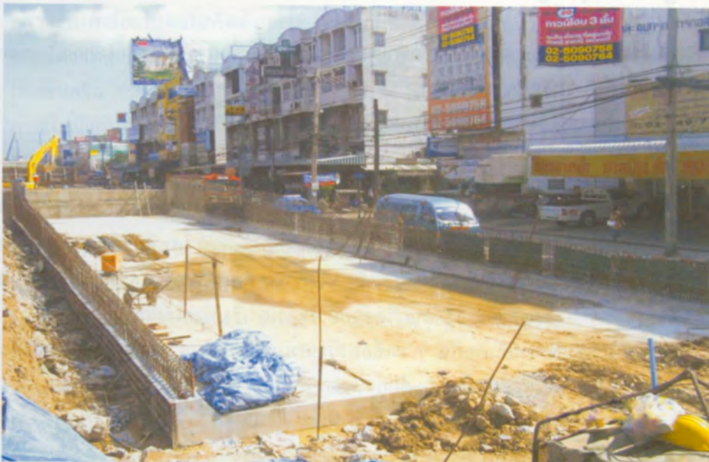
รูปที่ 7 Bearing Unit with Retaining Wall ขณะรอการประกอบแบบกำแพงด้านข้าง
