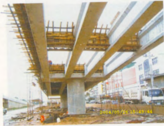
แบบหล่อ Intermediate Diaphragm
