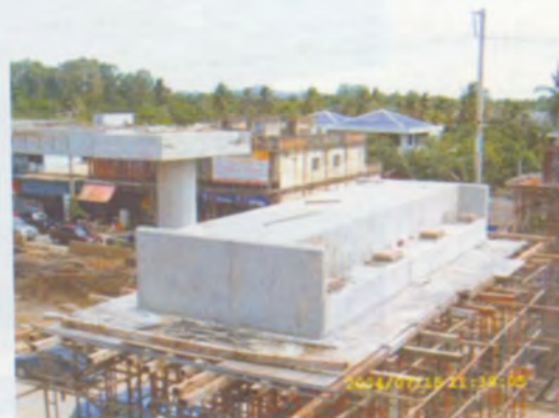
ถอดแบบ ตกแต่งผิว และบ่มคอนกรีต
