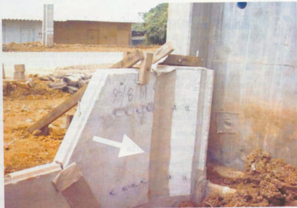
รูปที่ 6 แผ่นใยสังเคราะห์ปิดรอยต่อ (Geotextile Joint Filter)
