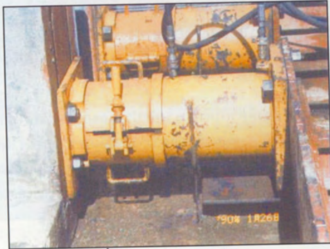
รูปที่ 4 แม่แรงลดแรงดึงลวด
