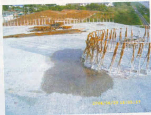
ตรวจสอบการไหลของน้ำบนผิวคอนกรีต
