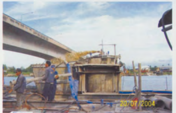
การทำความสะดวกด้านหลุมเจาะโดยวิธี Air Lift
