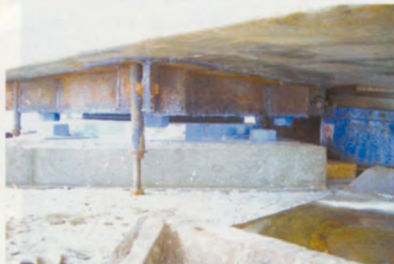
ติดตั้ง formwork
