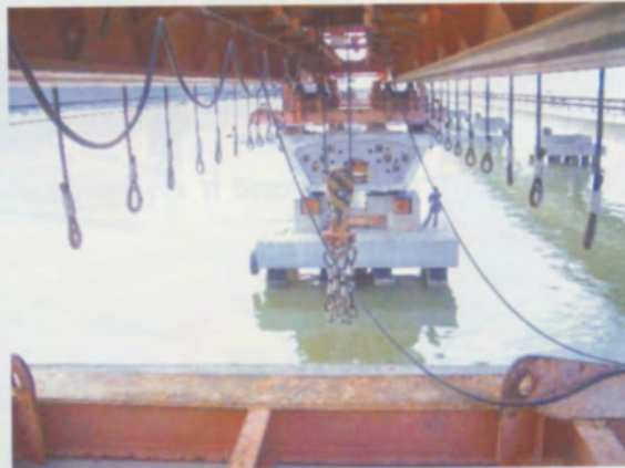
Girder อยู่ในตำแหน่งที่จะทำการยกขึ้นงาน
