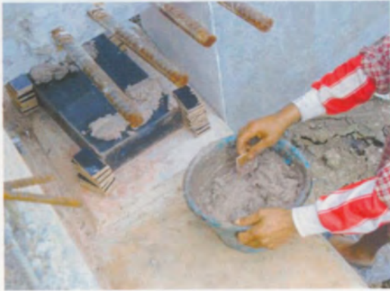
ใส่ Epoxy Mortar ให้สูงกว่าแผ่นไม้เล็กน้อย
