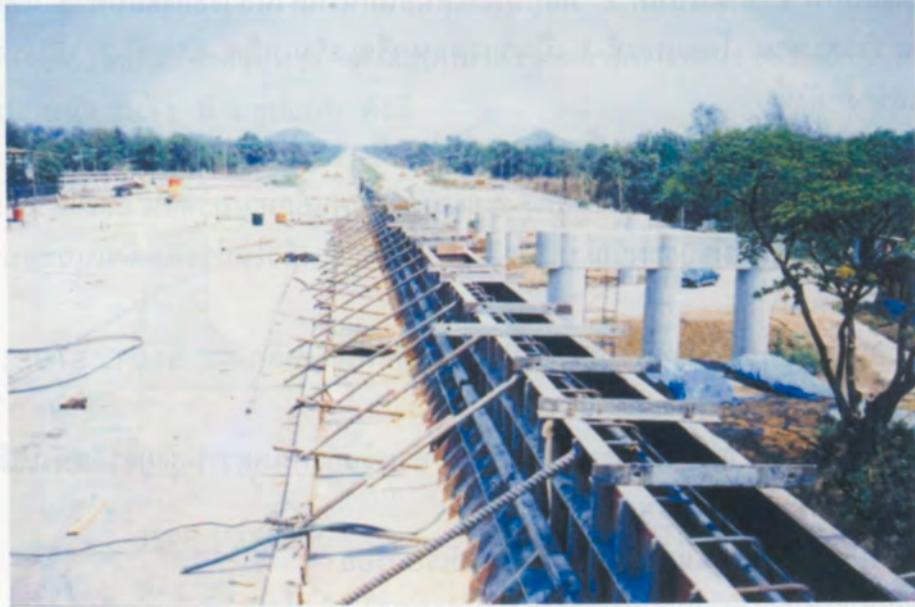
รูปที่ 2 แสดงการค้ำยันแบบขอบทางด้านหน้า
