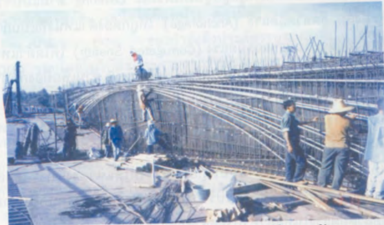
การติดตั้งท่อร้อยลวดอัดแรงคานคอนกรีตแบบดึงลวดอัดแรงภายหลัง
