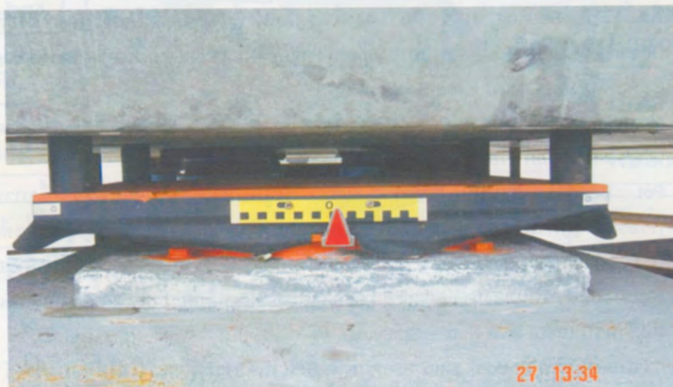
Pot Bearing ติดตั้งแล้วเสร็จใต้ Precast Box segment รอการ Grout ด้วย Non-shrinkage
