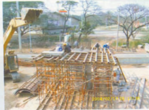
ปูห้องแบบในการก่อสร้างคานหัวเสา
