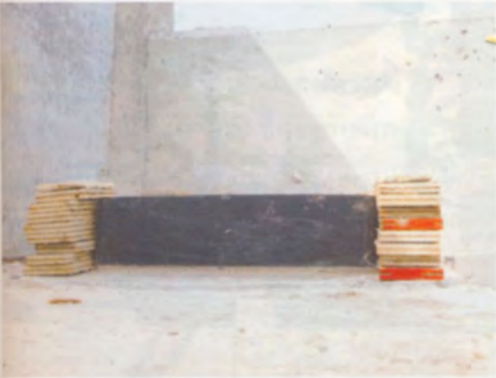
การติดตั้งแผ่นไม้สูงกว่าแผ่นยางประมาณ 1 ซม.
