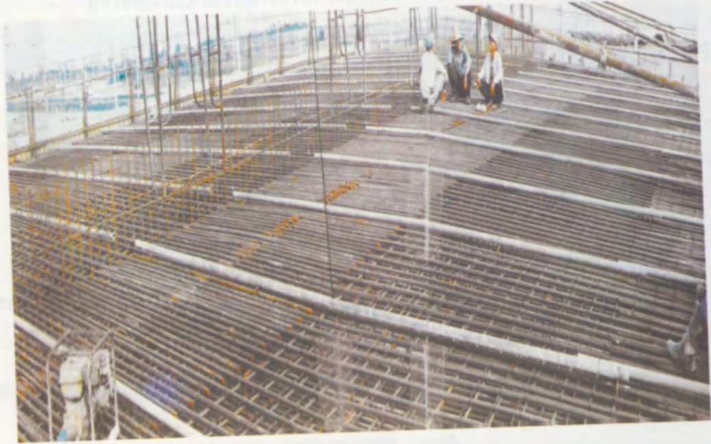
รูปที่ 12 การวางเหล็กควบคุมระดับ(ตามแนวขวาง)สำหรับการเทคอนกรีต
