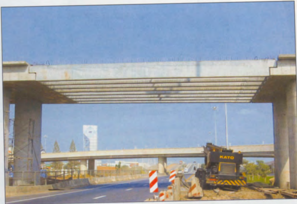
รูปภาพแสดงการจัดวางคานก่อนการติดตั้งแบบพื้นสะพาน
