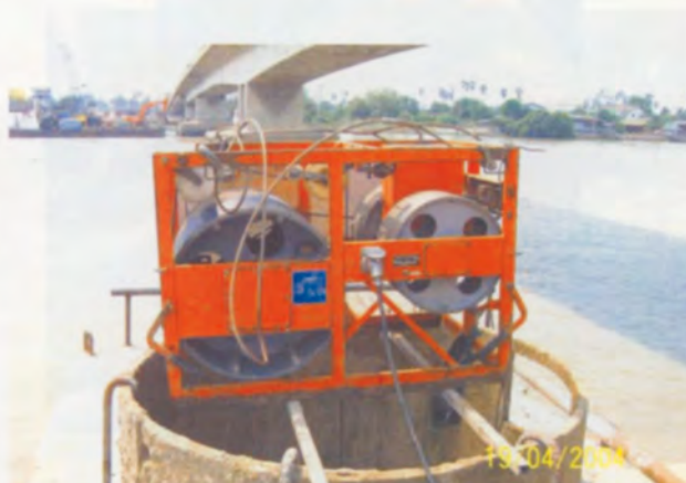
การตรวจสอบสภาพหลุมเจาะ (Drilling monitor) โดยใช้เครื่องมือ KODEN
