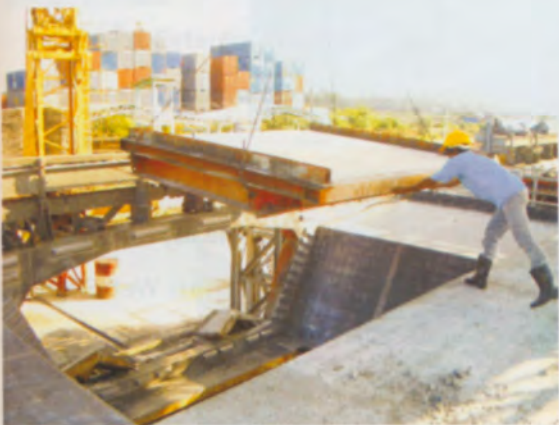
ยก Bottom Form เข้าติดตั้งให้ New Segment ตัวใหม่
