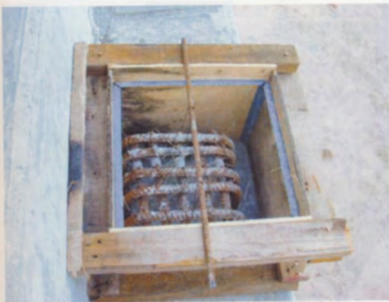
แบบหล่อ Seismic Buffer
