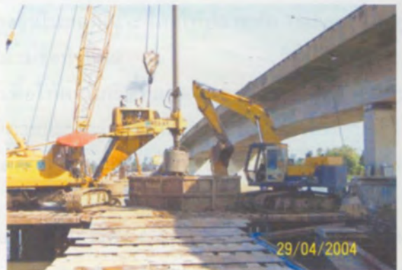
Bucket ขุดดินออกจากปลอกเหล็กเส้าเข็ม
