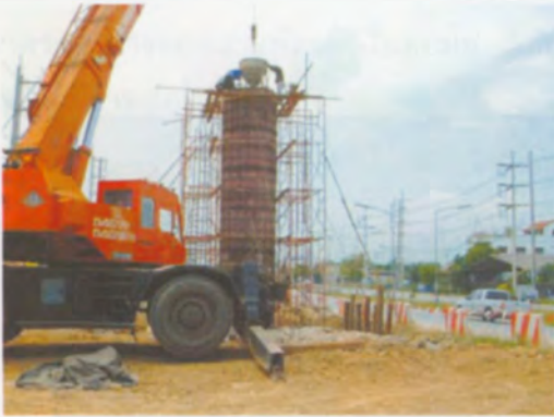
เทคอนกรีตด้วยรถยก ใช้ท่ออย่าง
