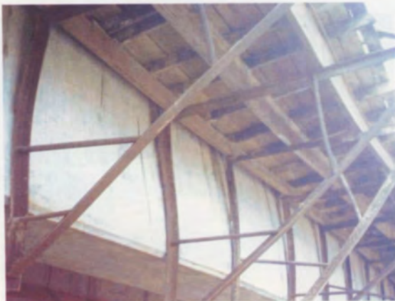
ปูห้องแบบบนค้ำยัน และเจาะช่องติดตั้งท่อระบายน้ำ
