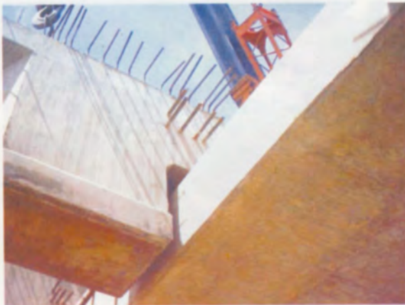
ตรวจสอบระยะห่างด้านล่างของขอบคานกับ Deck
