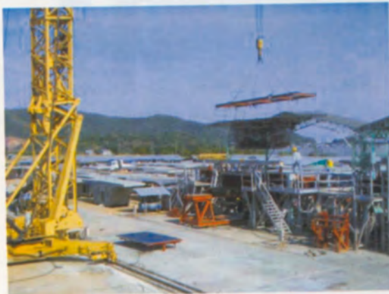
การนำโครงเหล็กเสริมเข้าติดตั้ง
