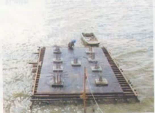
ตำแหน่งเสาเข็มเมื่อตอกแล้วเสร็จ
