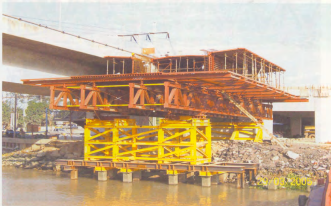
นั่งร้านชั่วคราวรับแบบหล่อคานช่วงริมฝั่ง (End Span)
