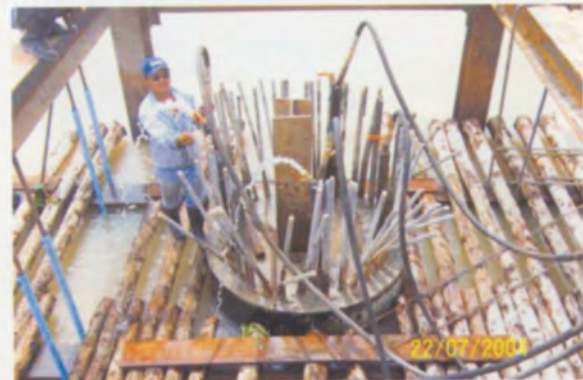
การอัดน้ำเพื่อตรวจสอบ Circuit Flushing
