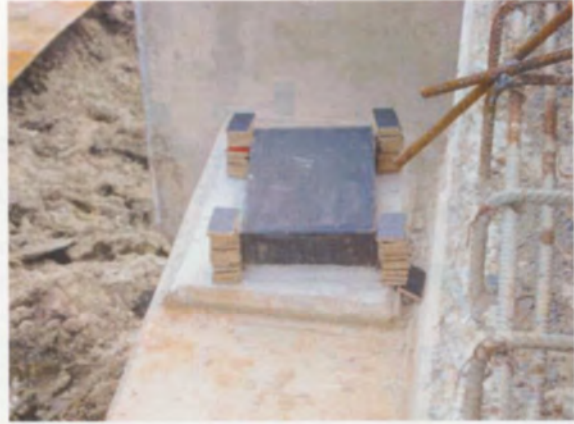
การติดตั้งแผ่นไม้รองรับคาน
