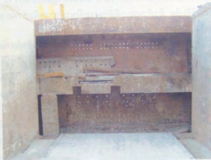
รูปที่ 3 แท่นสมอ ยึดลวดอัดแรง
