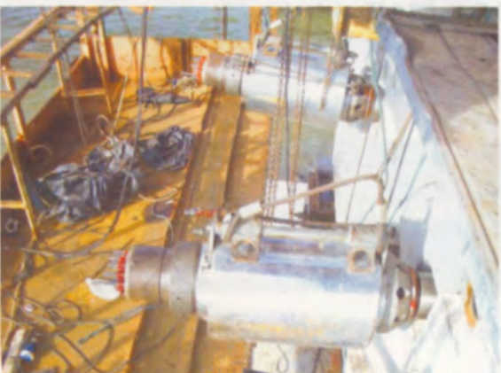
ดึงลวดอัดแรงคู่แรกด้วยแรงขนาด 15% ของ Jacking Force
