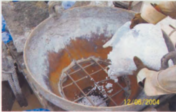
ใส่โฟมเม็ดลงไปในท่อ Tremie เพื่อแบ่งชั้นสารละลายกับคอนกรีตที่จะเท
