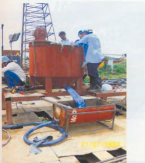
เครื่องผสมน้ำปูน (Grout Mixer) และถังวัดปริมาตร (Storage Tank)
