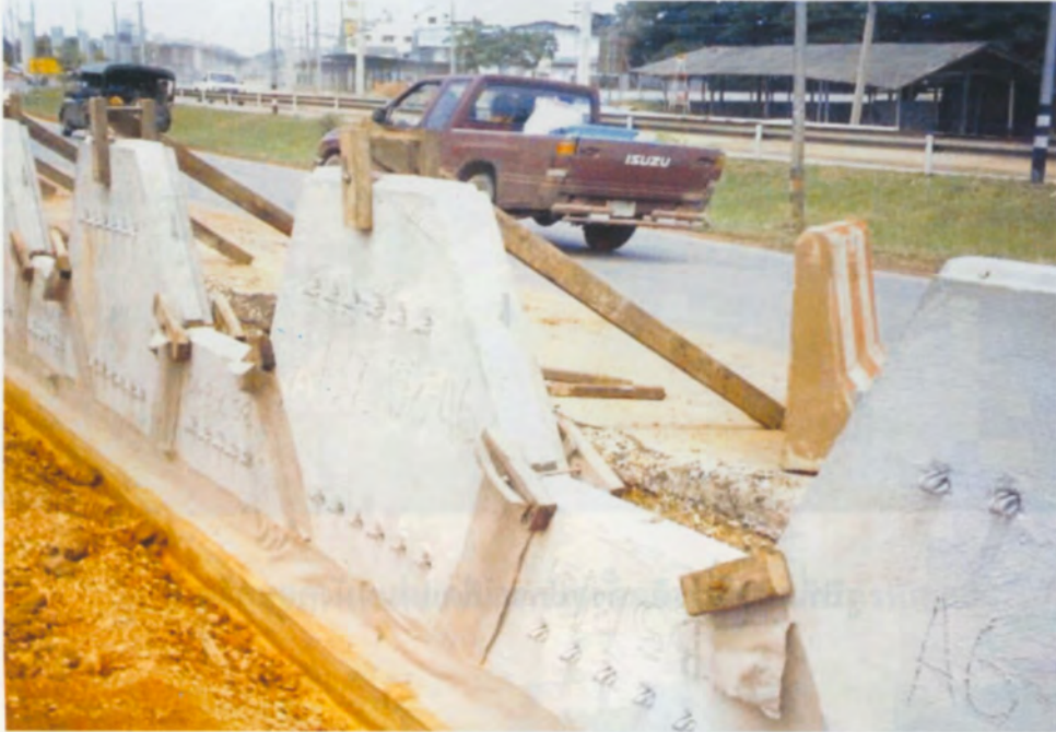
รูปที่ 24 การติดตั้งแผ่นใยสังเคราะห์ ปิดรอยต่อระหว่างแผ่นผนังคอนกรีต
