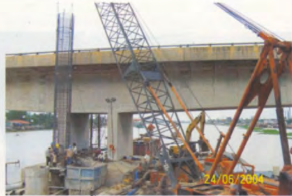
การติดตั้งเหล็กเสริมลงในเข็มเจาะ
