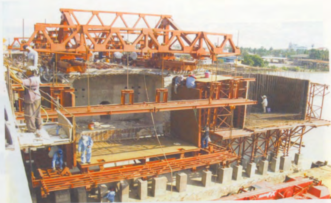
Pier Segment ที่ติดตั้ง Form Traveler แล้ว
