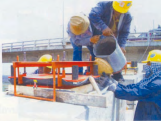
Grout Bottom Plate ของ Pot Bearing ด้วย High Strength Grout
