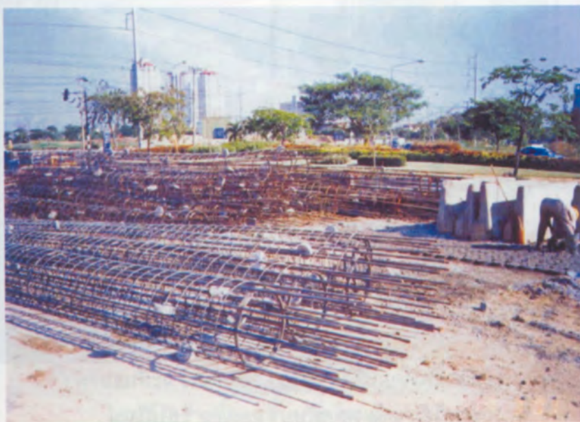
เหล็กเสริมเสาเข็มเจาะที่ผูกเตรียมไว้
