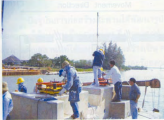
ติดตั้ง Pot Bearing
