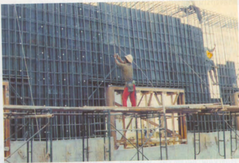
รูปที่ 7 การประกอบแบบหล่อกำแพง และช่องหน้าต่าง
