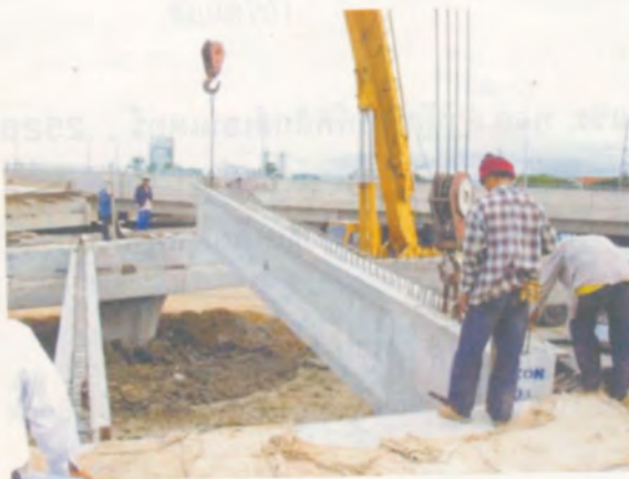
การเคลื่อนคานให้ตรงตำแหน่ง
