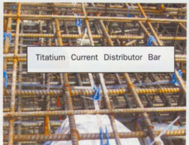
วาง Ribbon Mesh Andode และ Titatium Current Distributor Bar
