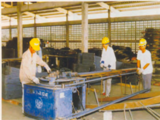
โรงตัดเหล็กเสริม
