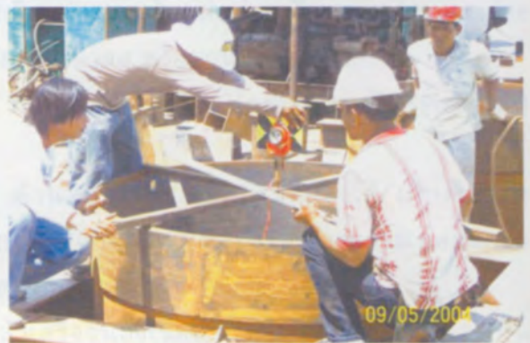
ตรวจสอบตำแหน่งของปลอกเหล็ก โดยมีความคลาดเคลื่อนไม่เกิน 10 ซม.
