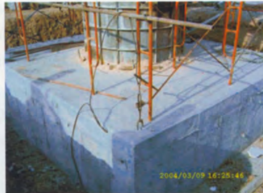
เหล็กยึดแบบเสา ฝังในฐานราก
