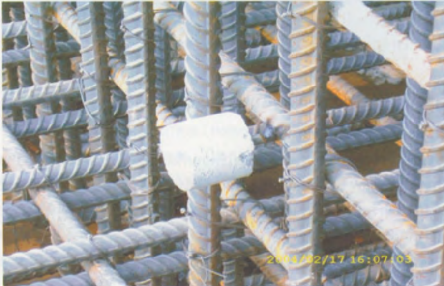
รูปที่ 3 การตรวจระยะคอนกรีตหุ้มเหล็กเสริม (Covering)
