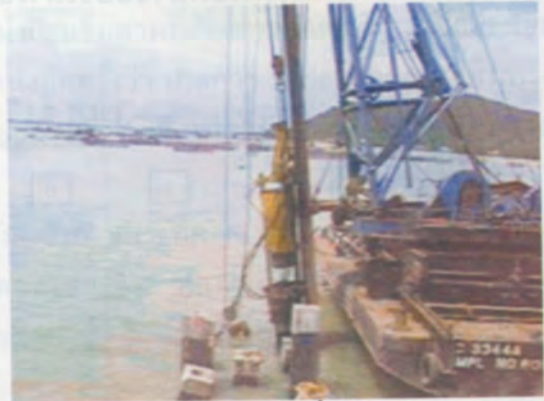
หัวตอกเสาเข็ม Hydraulic ยี่ห้อ Menck รุ่น MHF ตัมหนัก 5-10 Ton
