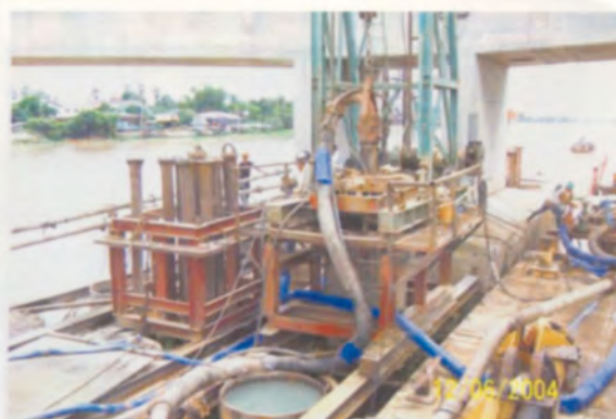
อุปกรณ์ขุดเจาะโดย วิธี Reverse Circulation
