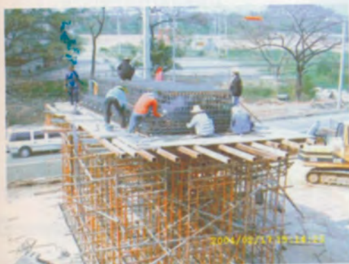
เสริมเหล็กคานหัวเสา
