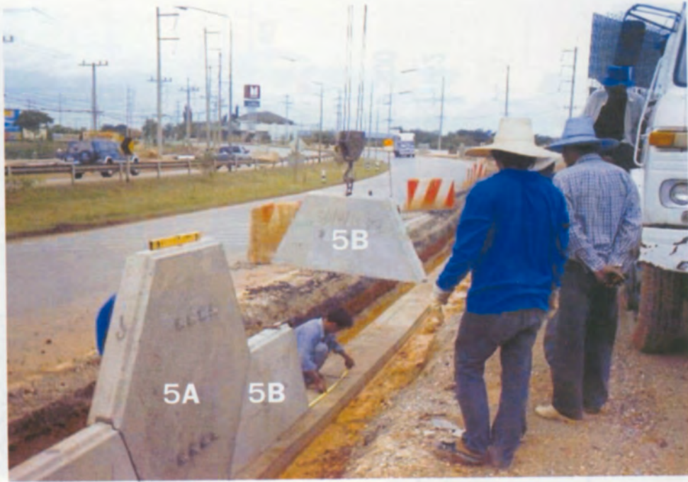
รูปที่ 20 การกำหนดช่องว่างการวางแผ่นผนังคอนกรีตรหัส 5B
