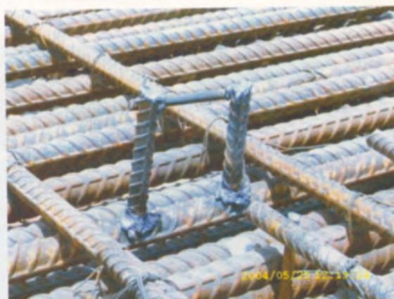
ติดตั้งขวางเหล็กยกระดับสำหรับการเทคอนกรีต
