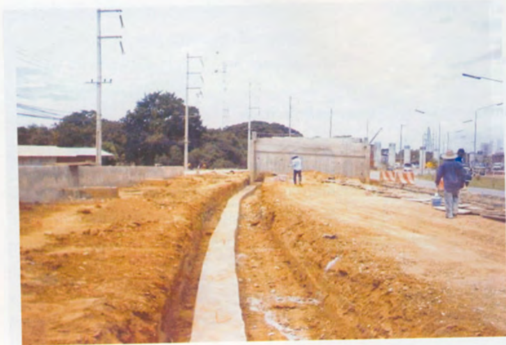
รูปที่ 14 การก่อสร้างฐานวางแผ่นผนังคอนกรีต
