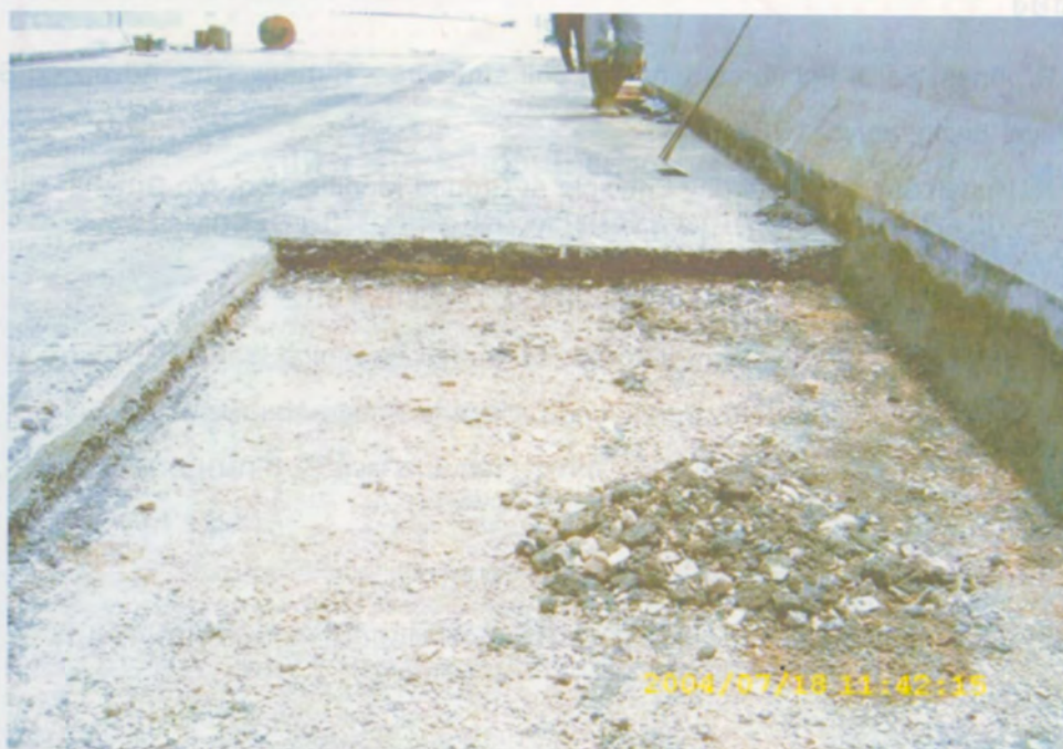
รูปที่ 35 การรื้อเพื่อซ่อมแซมโครงสร้างชั้นทาง
