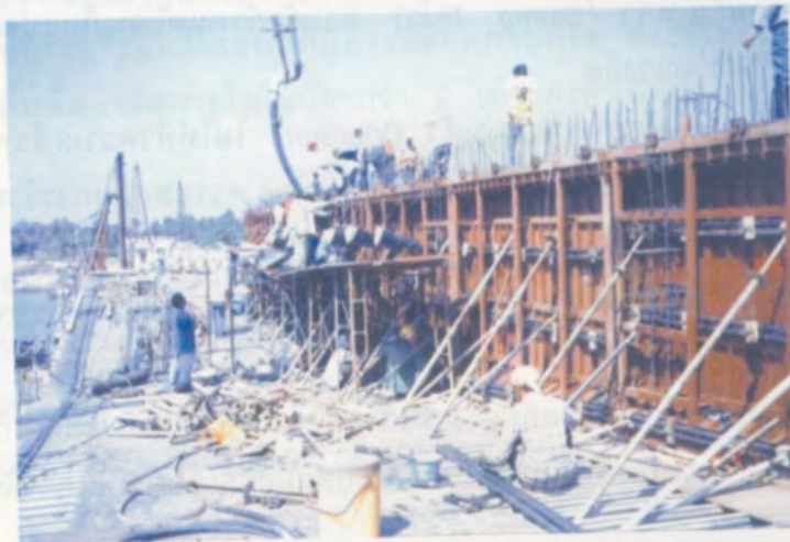
เทคอนกรีตด้วย Concrete Pump
