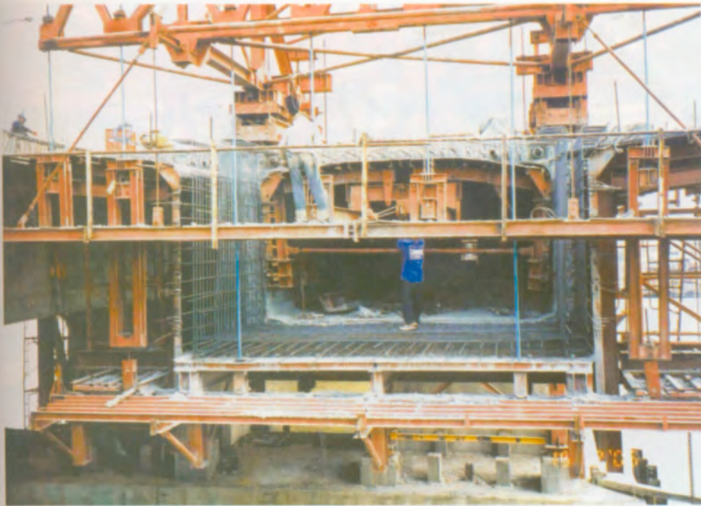
ผูกเหล็กเสริมในพื้นที่ล่าง (Bottom Slab) และกำแพง (Wall) ของ Segment
