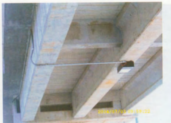
Seismic Buffer ที่ริมคานทั้งสองด้าน
