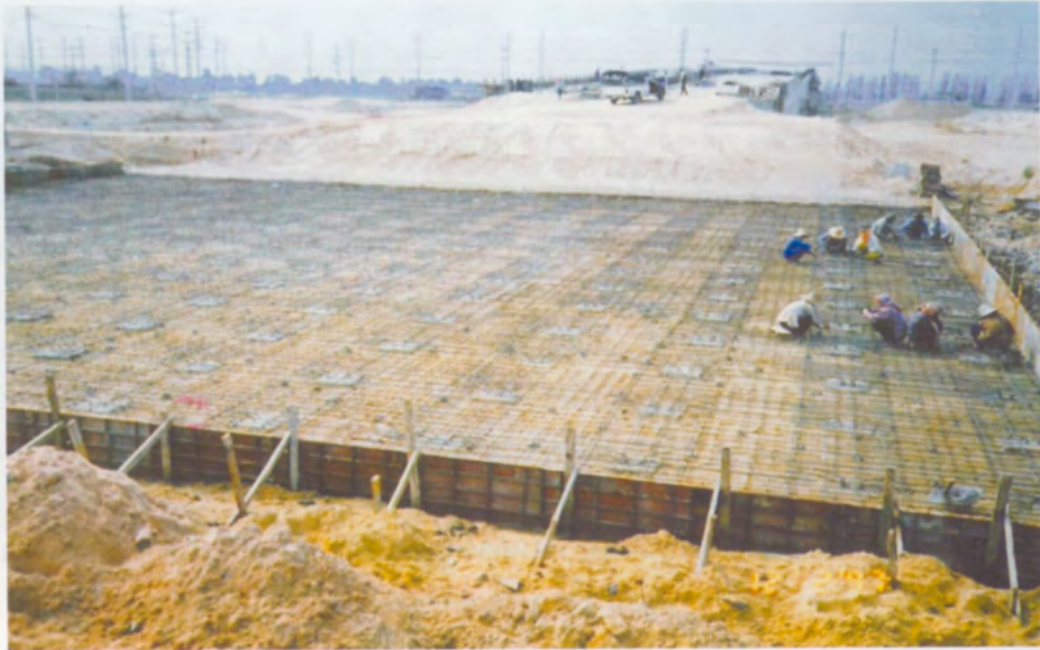
รูปที่ 4 ขั้นตอนงานเสริมเหล็ก
