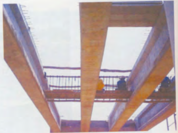
เหล็กเสริม Intermediate Diaphragm
