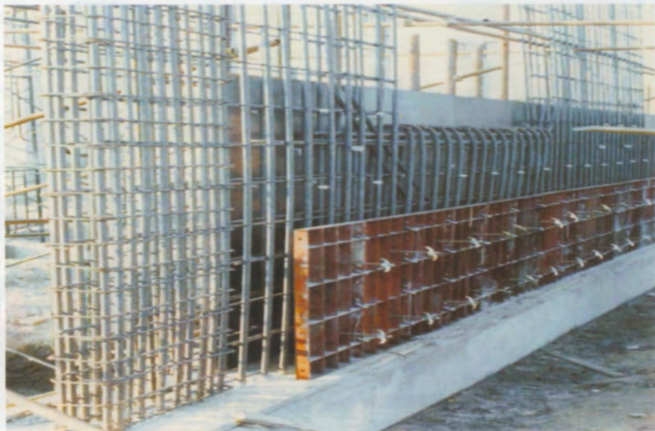
รูปที่ 6 งานหล่อกำแพง บนคานคอดิน
