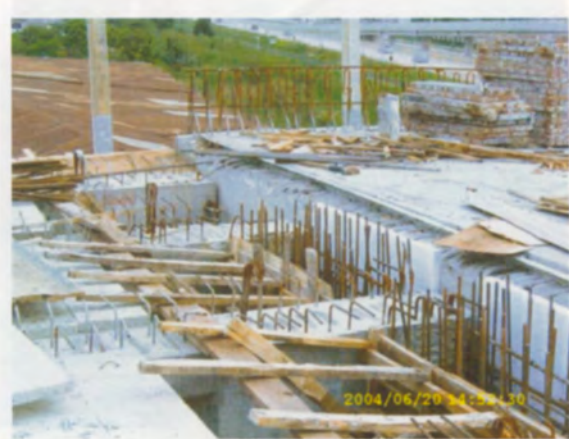
ติดตั้งโฟมกันระหว่าง End Diaphragm กับ Crosshead
