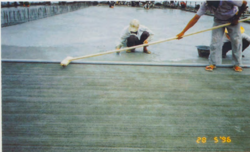
รูปที่ 14 งานตกแต่งผิวพื้นบนโดยใช้ Steel Trowel
