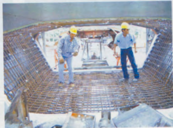
การนำโครงเหล็กเสริมเข้าติดตั้ง
