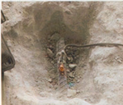
เชื่อมต่อ Ground Connection ด้วยวิธี Termite Melting
