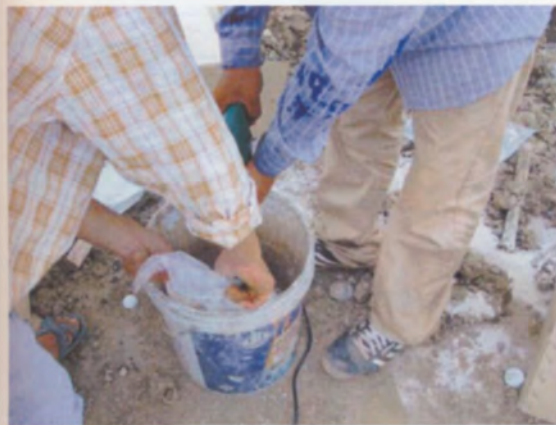
เติมทรายที่มากพร้อมชุด Epoxy
