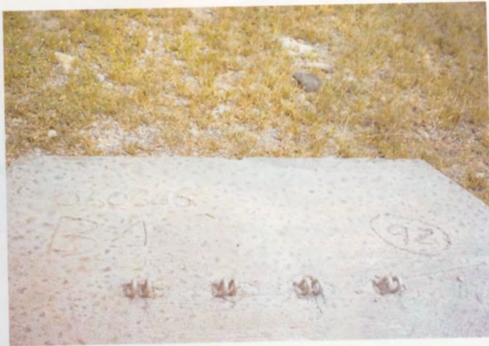
รูปที่ 13 การเขียนรายละเอียดบนแผ่นผนังคอนกรีต
