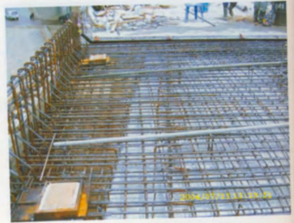
ติดตั้งท่อระบายน้ำ
