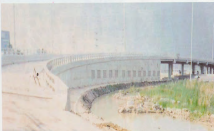
รูปที่ 2 Bridge Approach Structure ที่อยู่ในช่องทางโค้ง
