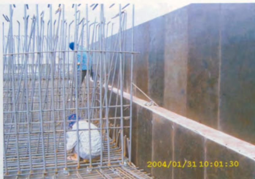
รูปที่ 9 การเสริมเหล็กตามแบบ ประกอบแบบด้านข้าง
