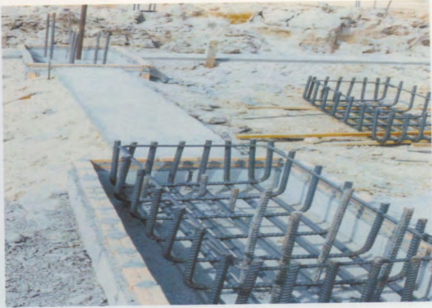
รูปที่ 3 งานเหล็กเสริมแทนหัวเข็ม
