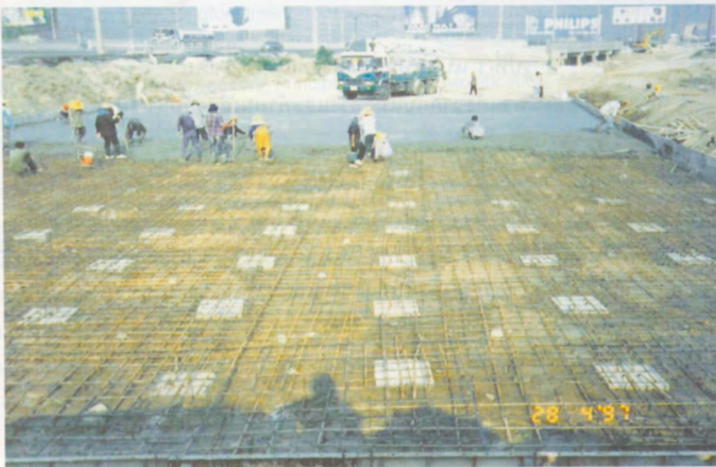
รูปที่ 5 ขณะเทคอนกรีต
