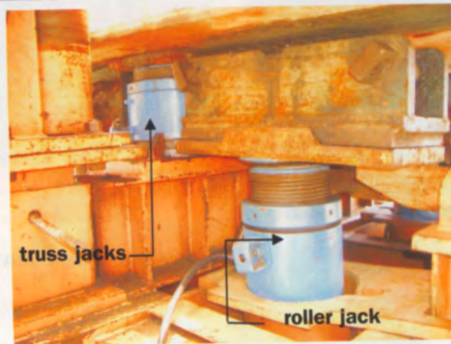
Roller jack และ Girder jacks
