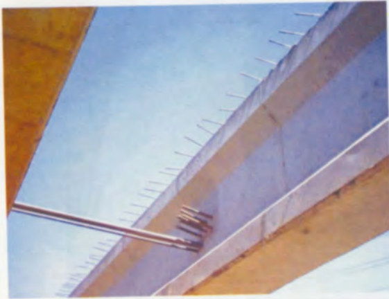
เหล็กเสริม Intermediate Diaphragm
