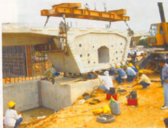
ยก Pier Segment ขึ้นติดตั้งบน Pier Column
