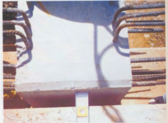
ตรวจสอบระยะห่างปลายคานกับ Deck ให้เท่ากันทั้งสองปลาย
