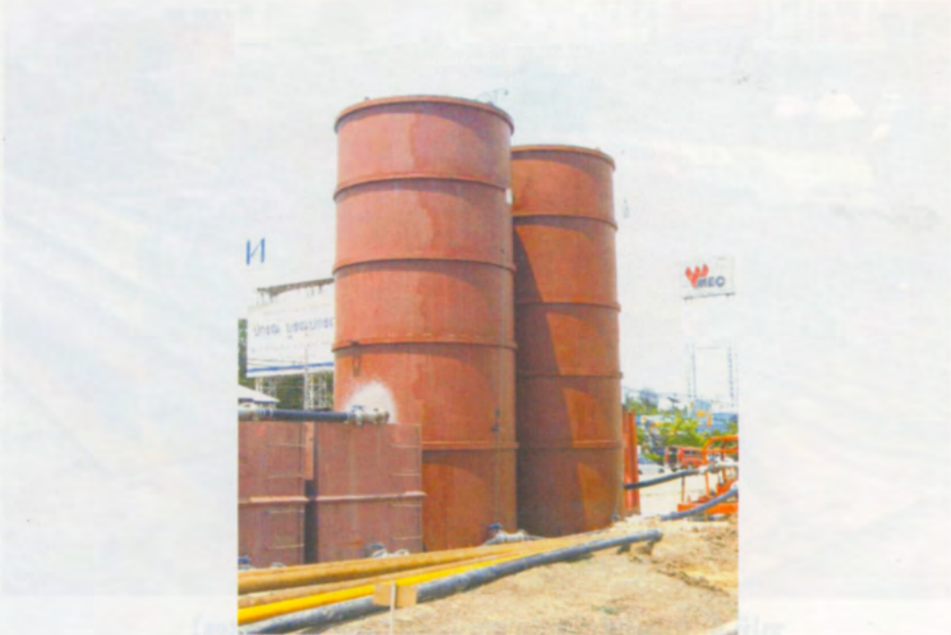
รูปที่ 7 ถังเก็บของเหลวของเสถียรภาพหลุมเจาะ
