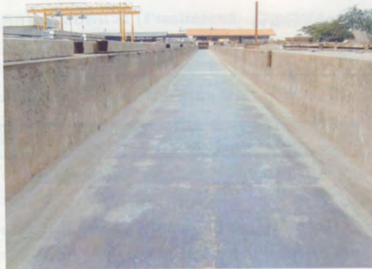
รูปที่ 2 ฐานหล่อคาน
