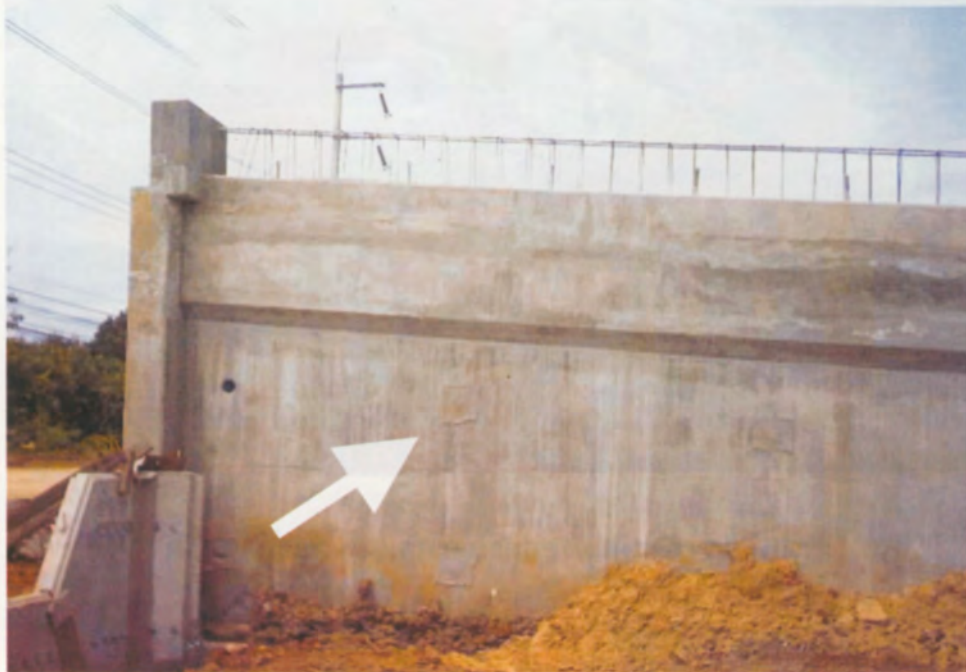
รูปที่ 25 การติดตั้งแผ่นใยสังเคราะห์ ปิดระบายน้ำของผนัง Abutment
