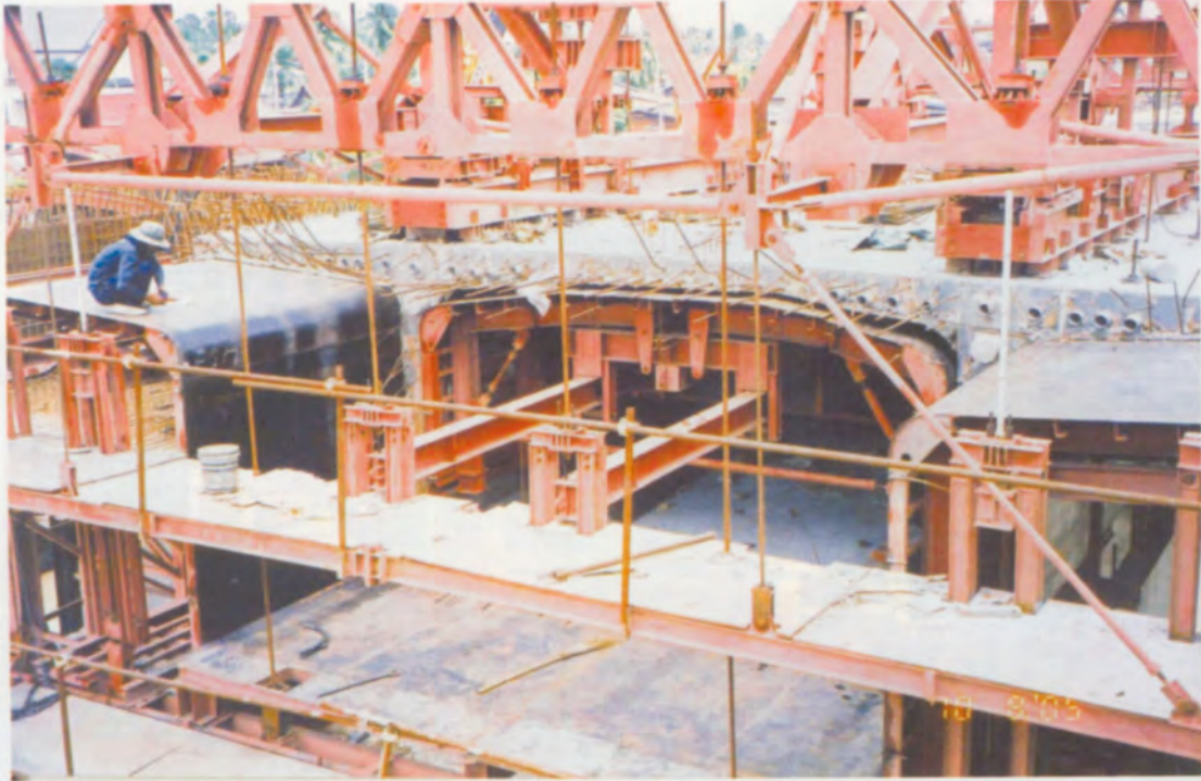
ตัดทำความสะอาดแบบหล่อด้านนอก (Outer Form) ของ Segment
