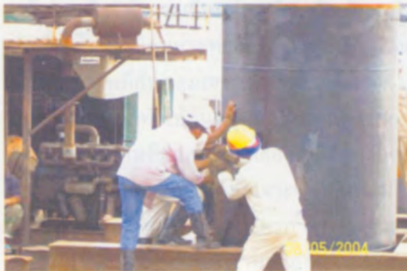
ตรวจสอบแนวตั้งของปลอกเหล็ก โดยมีความเบี่ยงเบนแนวตั้งไม่เกิน 1 : 100
