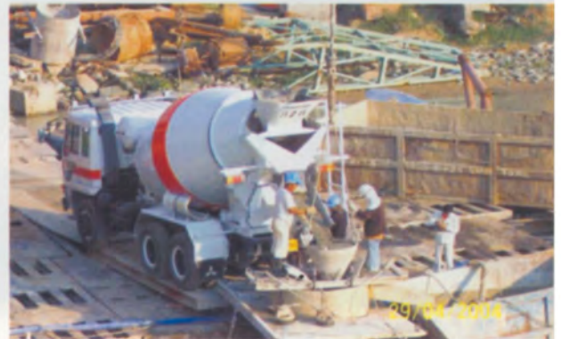
การเทคอนกรีตเสาเข็มเจาะ
