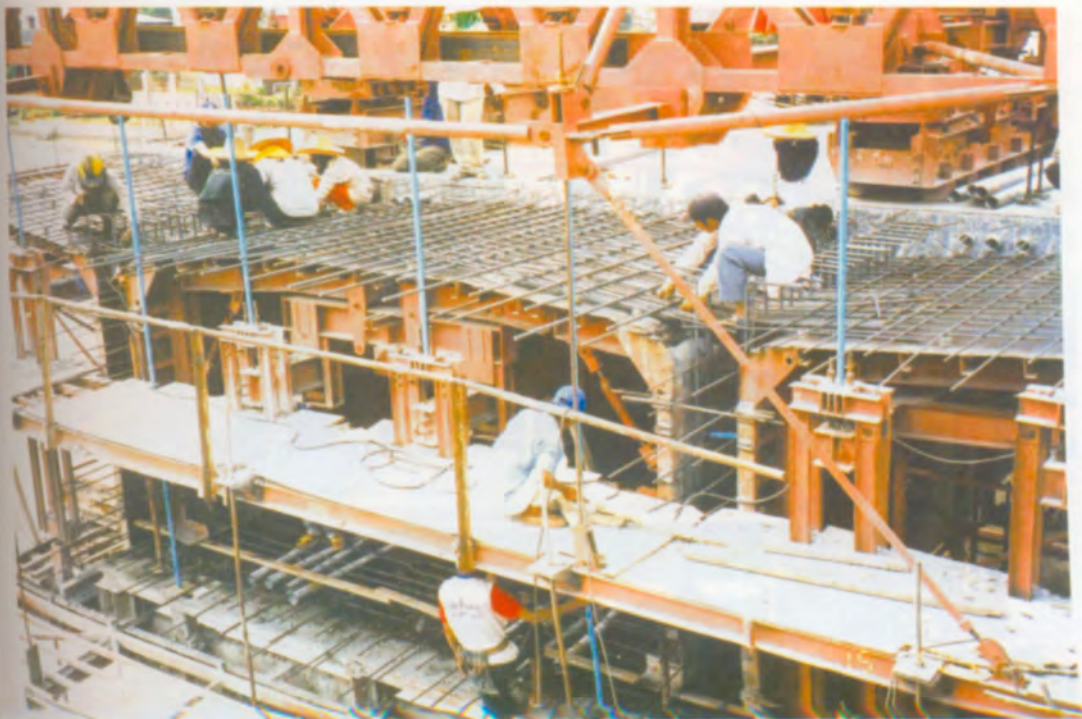
ผูกเหล็กเสริมในพื้นที่บน (Top Slab) ของ Segment
