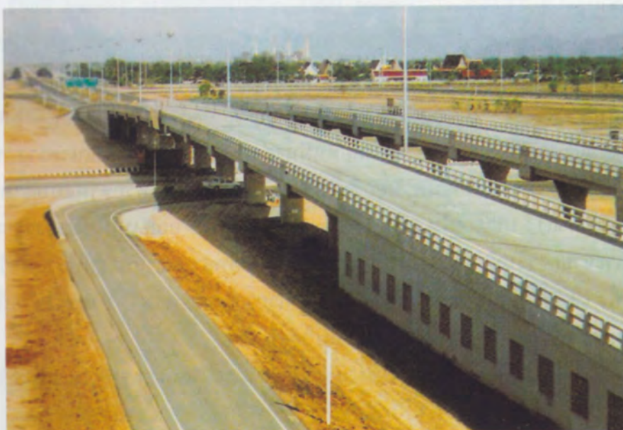
รูปที่ 1 สะพานที่มี Bridge Approach Structure
