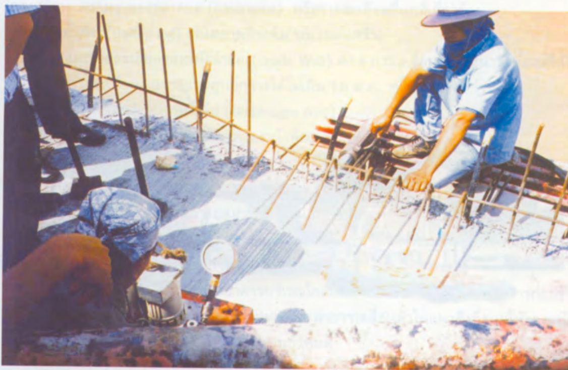
การดึงลวดอัดแรงใน Transverse Tendon ด้วยแรงที่แบบกำหนด
