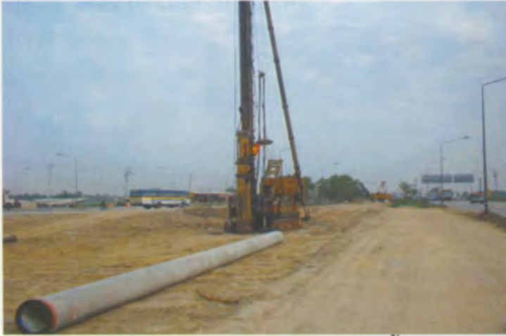
รถเครนดินตะขาบ ติดตั้งไฮดรอลิคแฮมเมอร์
