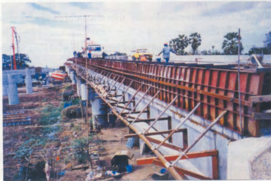
รูปที่ 3 แสดงการค้ำยันแบบขอบทางด้านหลัง
