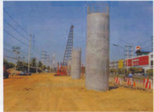
บ่มคอนกรีต(พันพลาสติกและรดน้ำด้านบน)
