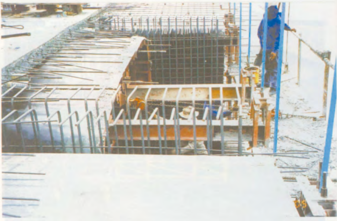
เลื่อนแบบหล่อด้านใน (Inner Form) ของ Segment ด้วยรอกทอต เพื่อทำความสะอาด
