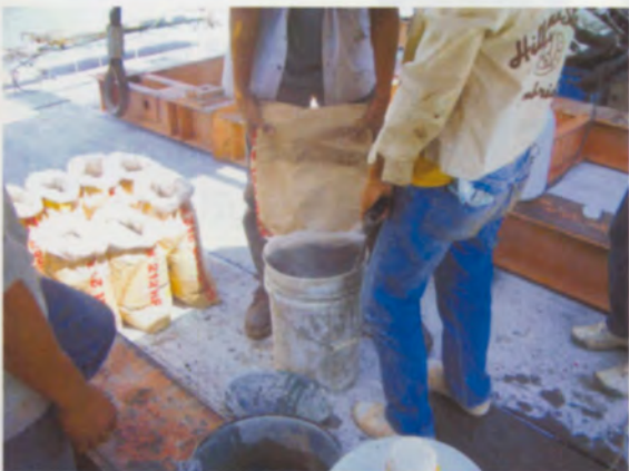
เตรียม High Strength Grout
