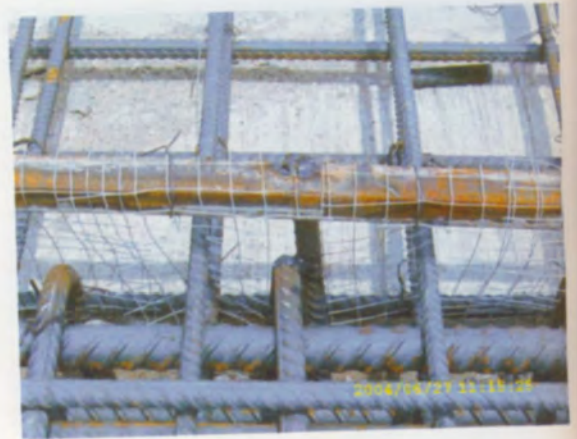
ติดตั้งตะแกรงกันคอนกรีต
