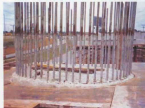
กำหนดระดับการเท ที่ท้องคานหัวเสา
