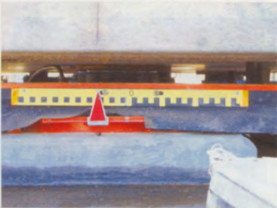
ตั้งค่า Pre-Setting ของ Top Plate
