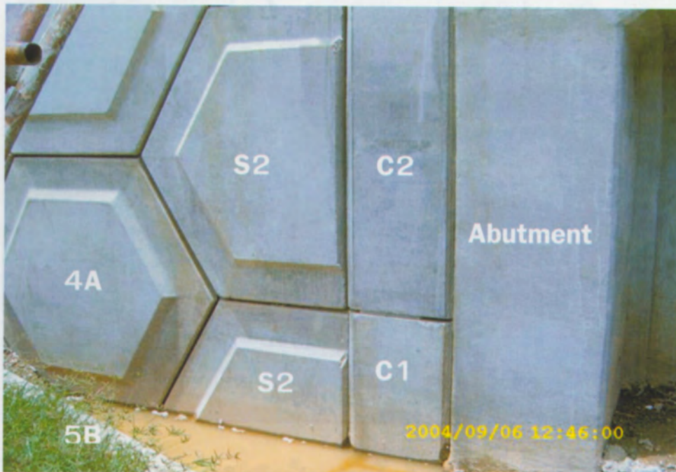
รูปที่ 19 ลำดับการก่อสร้างเริ่มต้นจากมุมของ Abutment
