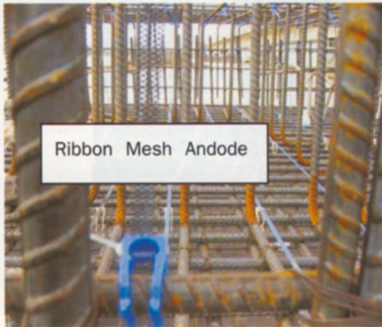
วาง Ribbon Mesh Andode และ Titatium Current Distributor Bar
