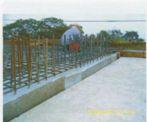
End Diaphragm และ Crosshead
