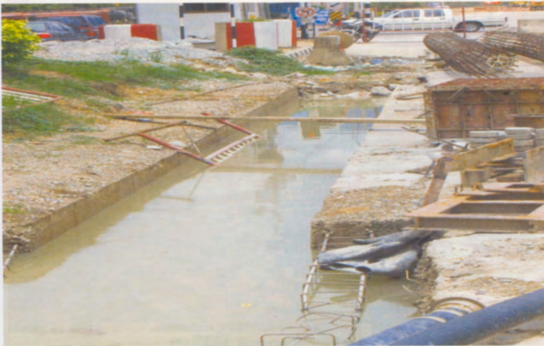
แสดงหลุมขุดระหว่าง Guide Wall
