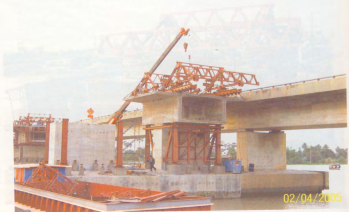
ติดตั้งโครงเหล็ก Form Traveler บน Pier Segment
