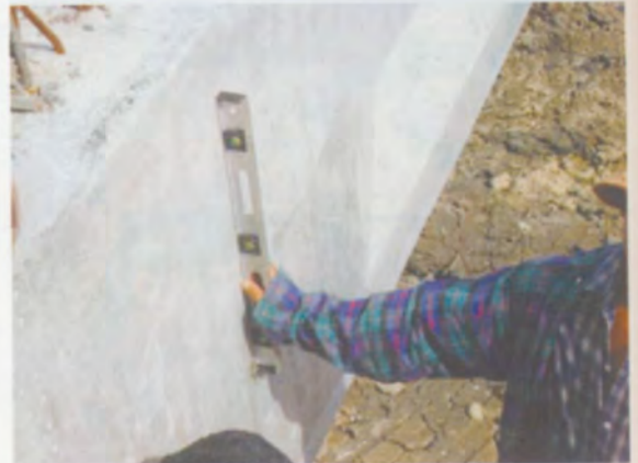
ตรวจสอบแนวตั้งด้านข้างคาน
