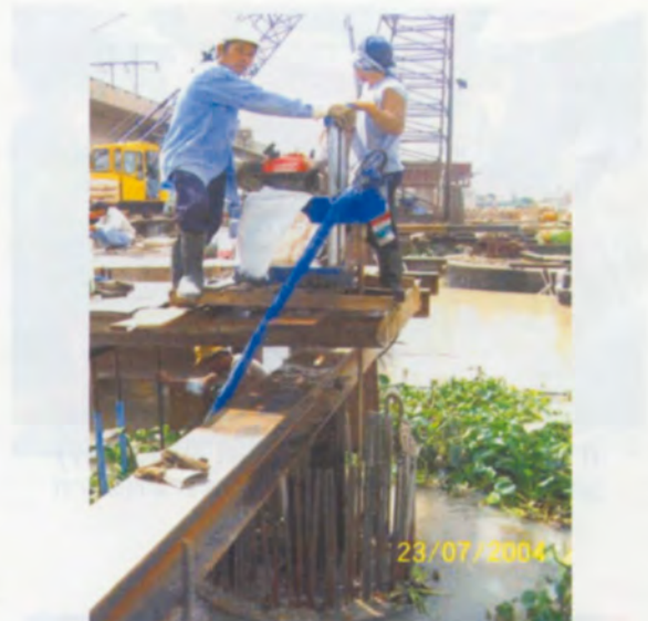
การเจาะคอนกรีตที่ปลายท่อเหล็ก สำหรับทำ Sonic Logging จนทะลุถึงชั้นดิน
