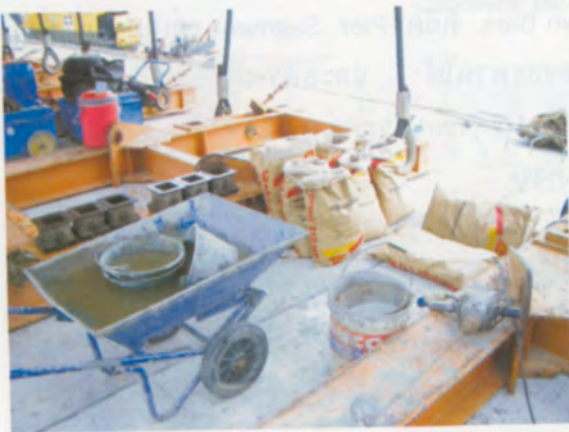
Grout ด้านบนของ Pot Bearing
