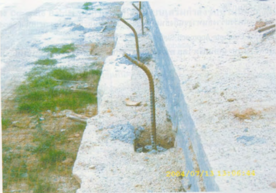
รูปที่ 33 การก่อสร้างสมอคอนกรีตสำหรับยึด Concrete Barrier
