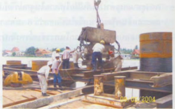
ปักปลอกเหล็กเส้าเข็มลงในคอกซึ่งกำหนดตำแหน่งไว้ตามแบบ
