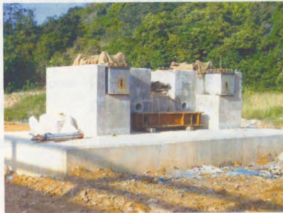
พ่นน้ำยาบ่มคอนกรีตและคลุมด้วยกระสอบ
