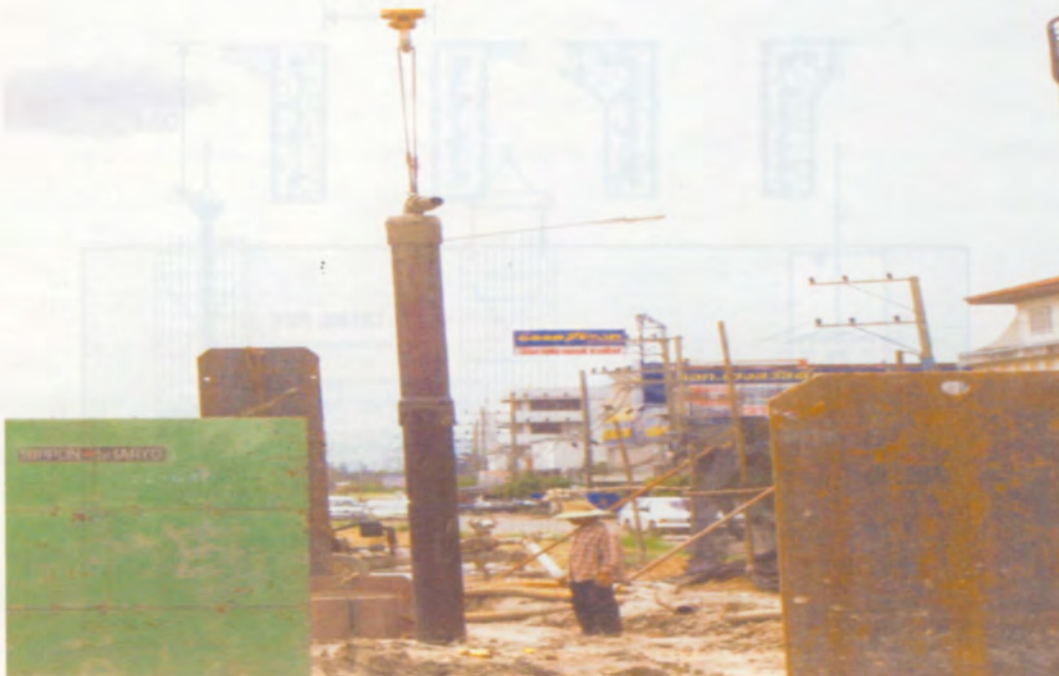
ท่อดูดทำความสะอาดกันหลุม
