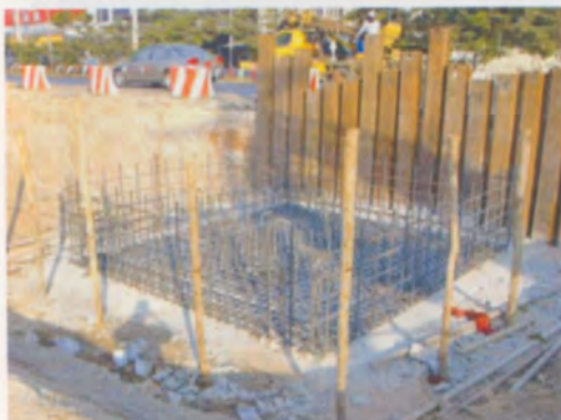
เสริมเหล็กฐานราก
