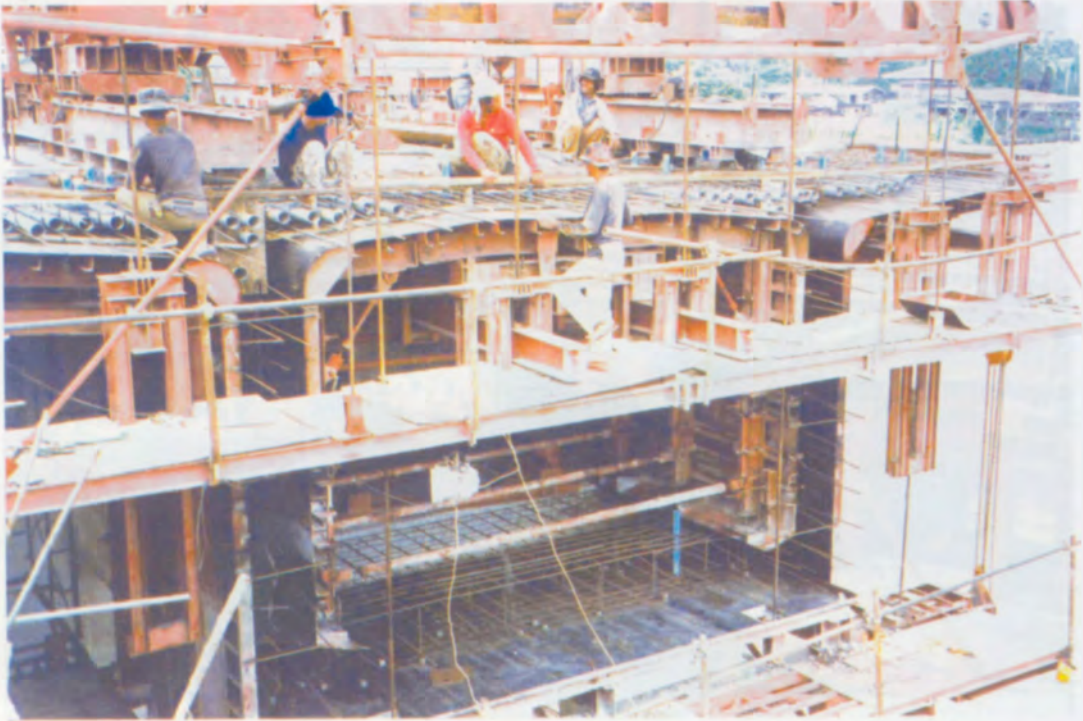
การปิดแบบด้านขวางของ Segment ด้วยตะแกรงเหล็กชุบสังกะสี เพื่อกันคอนกรีต
