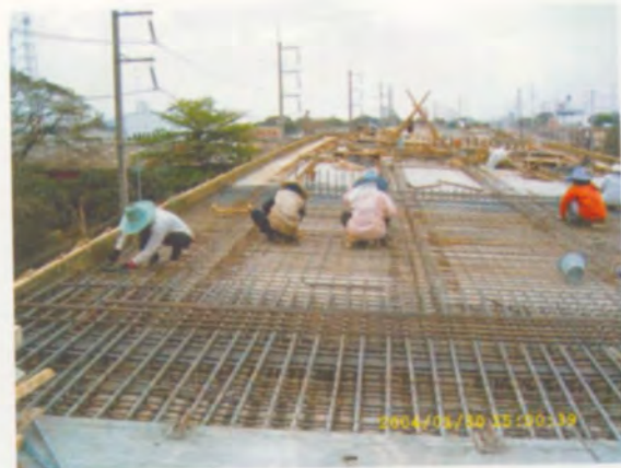
เสริมเหล็กกลาง และที่ Crosshead
