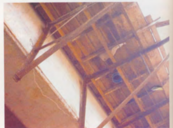
ปูห้องแบบบนค้ำยัน และเจาะช่องติดตั้งท่อระบายน้ำ
