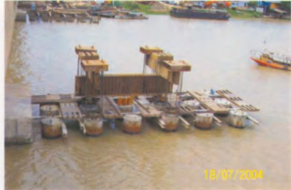
การทดสอบ Static Pile Load Test
