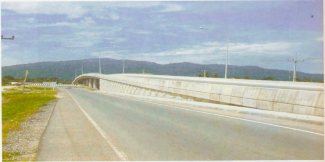
รูปที่ 36 การก่อสร้างแล้วเสร็จตามแบบ
