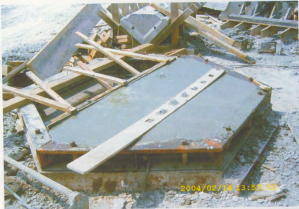
รูปที่ 12 การติดตั้งสมอยึดรั้งแผงตะแกรงเหล็กเสริม
