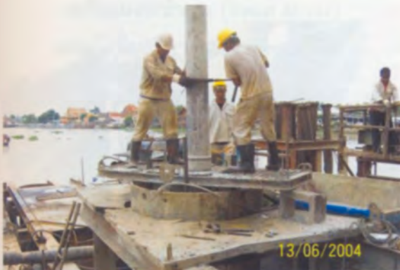
ต่อท่อ Tremie สำหรับเทคอนกรีต
