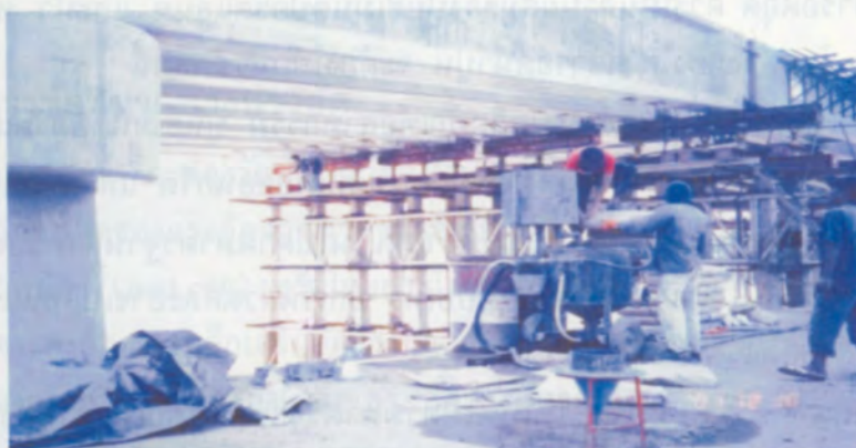
การติดตั้งอัดแรงในบริเวณหน้างาน
