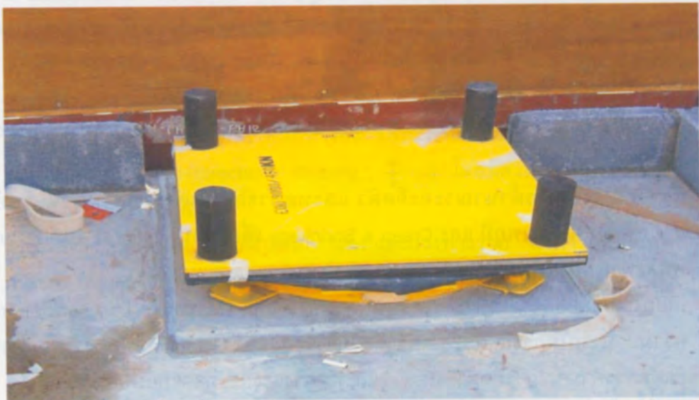
Pot Bearing ที่ติดตั้งบนตอม่อ โดยเทคอนกรีต Non-shrinkage แล้วเสร็จ
