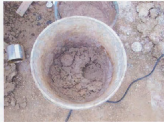
Epoxy Mortar ที่ผสมแล้วเสร็จ
