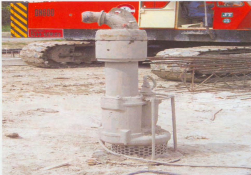
รูปที่ 4 เครื่องสูบของเหลวขุ่นเสถียรภาพออกจากหลุมเจาะขนาดเส้นผ่านศูนย์กลางท่อ 8"
