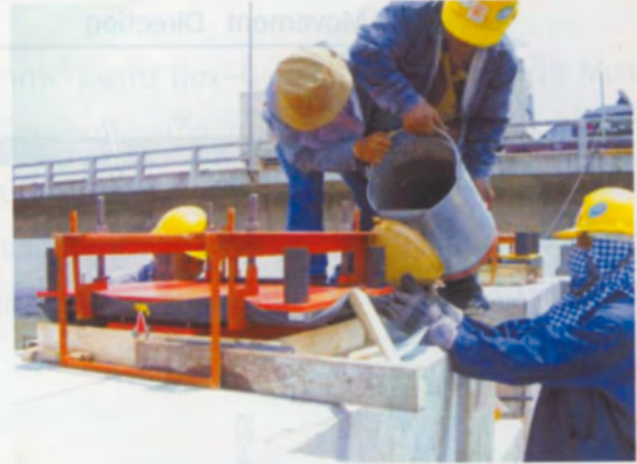
Grout ด้านล่างของ Pot Bearing
