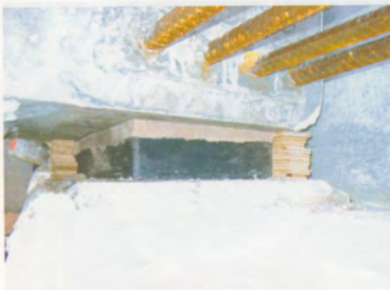
วางคานบนแผ่นไม้แล้ว แต่ง Epoxy Mortar โดยรอบแผ่นยาง
