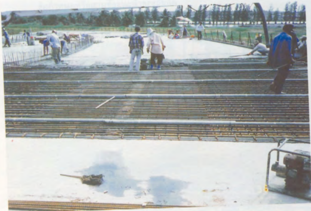
รูปที่ 13 งานเทคอนกรีตพื้นบน
