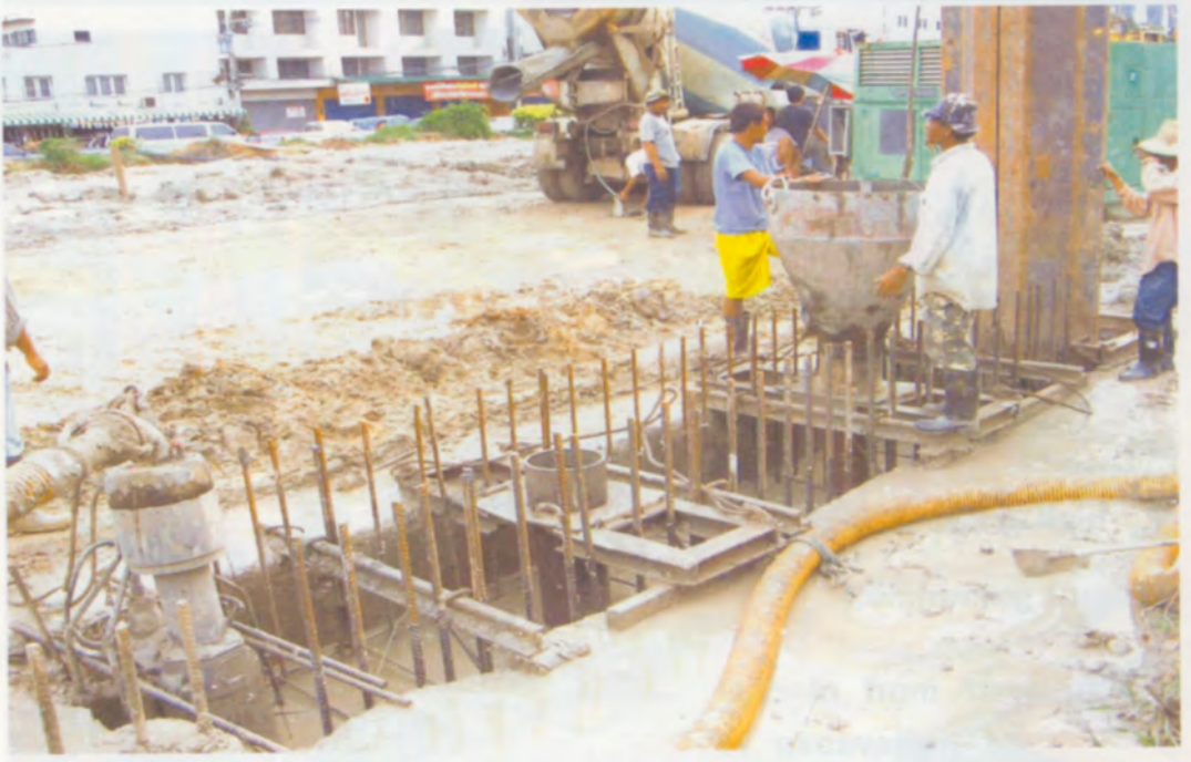
การปรับความยาวท่อให้เหมาะสมและสัมพันธ์กับปริมาณคอนกรีต
