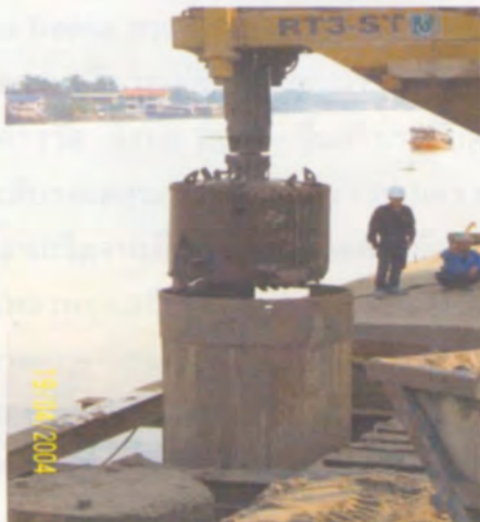
Bucket ขุดดินออกจากปลอกเหล็กเส้าเข็ม
