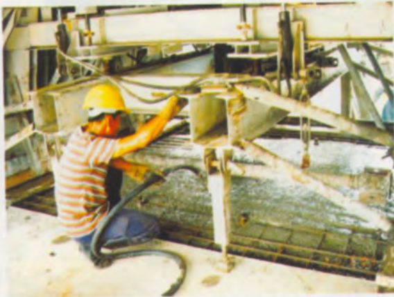
เท Bottom Slab
