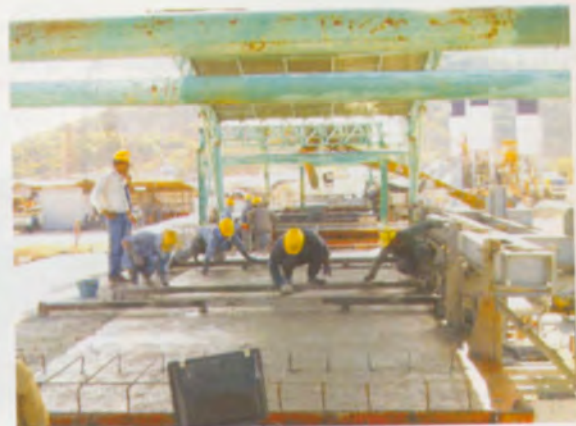
แต่งหน้าคอนกรีต
