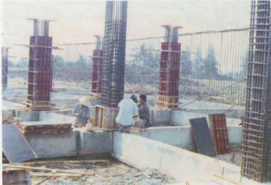
รูปที่ 5 งานหล่อเสา (Column)
