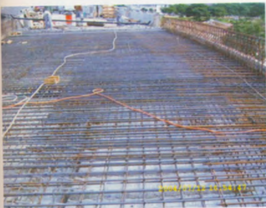
เสริมเหล็กบนยึดด้วย Bar Chair
