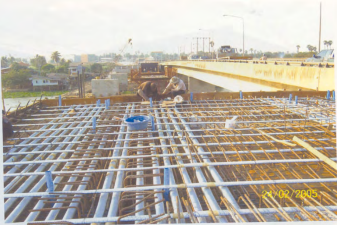
ตำแหน่งท่อร้อยลวดอัดแรงตามแนวยาวและตามแนวขวาง
