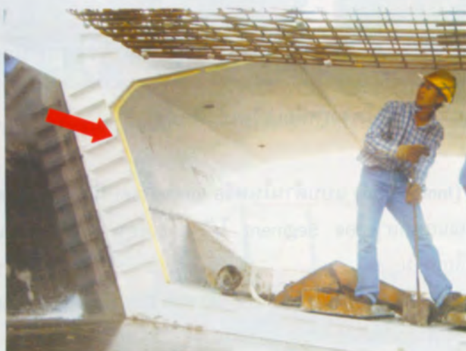
อุดช่องว่างด้วย ซิลิโคน ป้องกันน้ำปูนไหลขณะเทคอนกรีต
