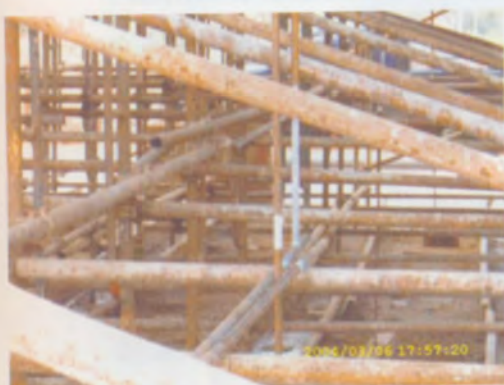
เหล็กมัดการทูลตัว ระหว่างเทคอนกรีต
