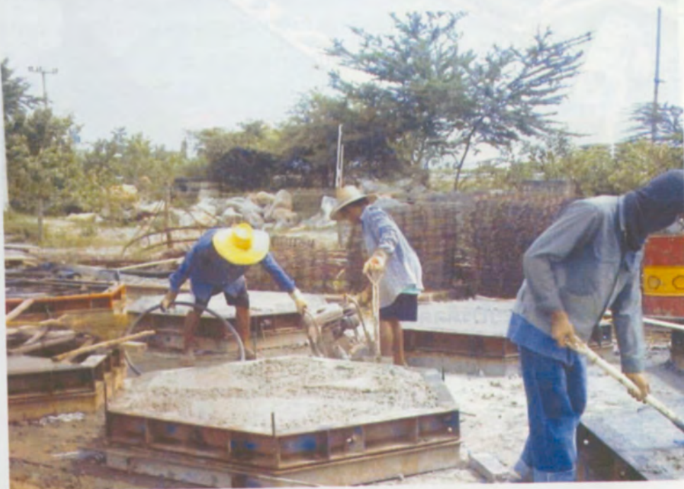
รูปที่ 11 การเทคอนกรีตในแบบหล่อ
