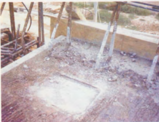
แต่งคอนกรีตรอบตำแหน่งท่อระบายน้ำ และนำแบบออก
