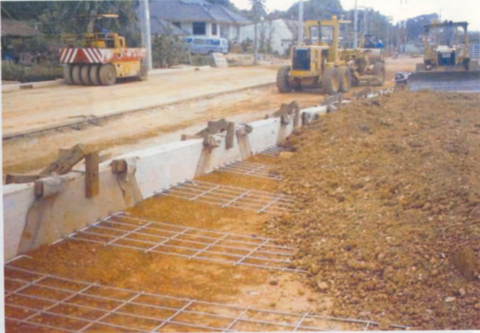
รูปที่ 26 การลงวัสดุดินถม (Granular Materials)
