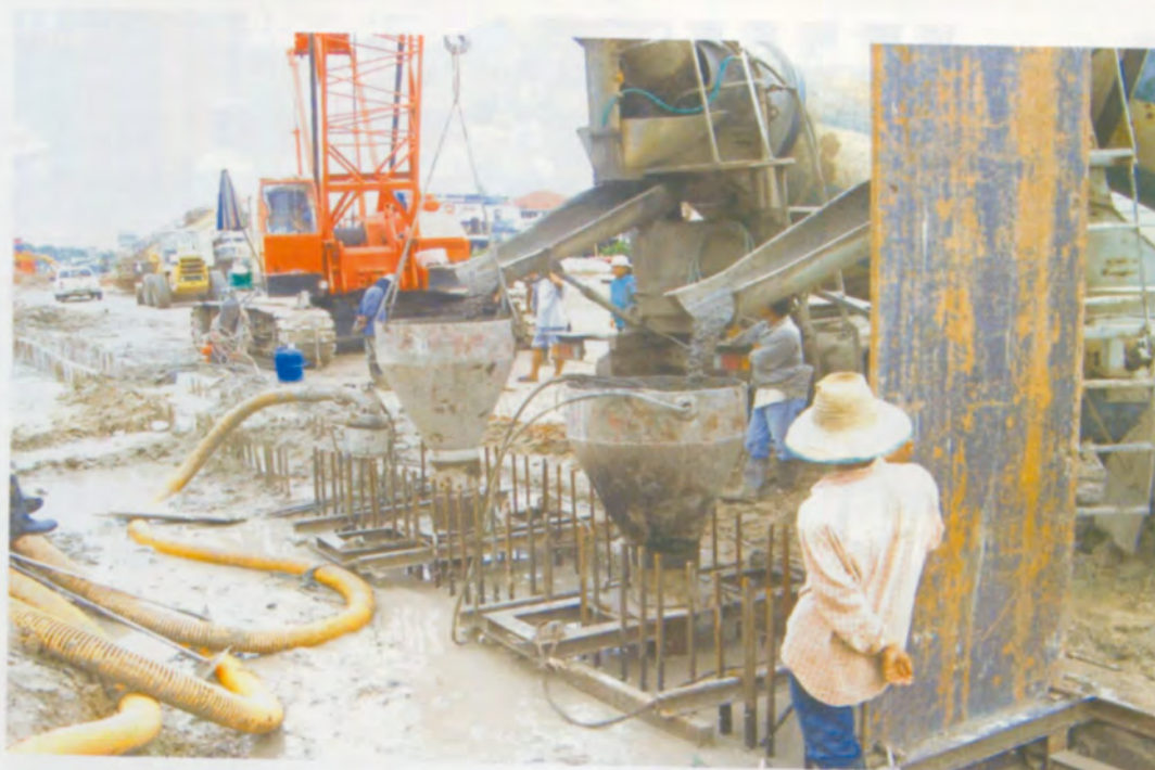
การเทคอนกรีตผนังพืด (Diaphragm Wall) โดยใช้ท่อเทคอนกรีต (Tremie Pipe)
