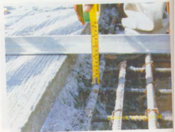
ตรวจสอบระยะ Covering และความหนาพื้น
