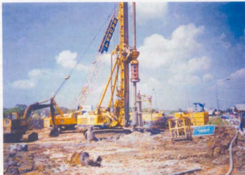
ขุดเจาะดินด้วยเครื่องจักรและหัวเจาะแบบ Bucket
