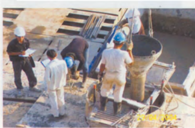
ต่อท่อ Tremie และกรวย สำหรับเทคอนกรีต
