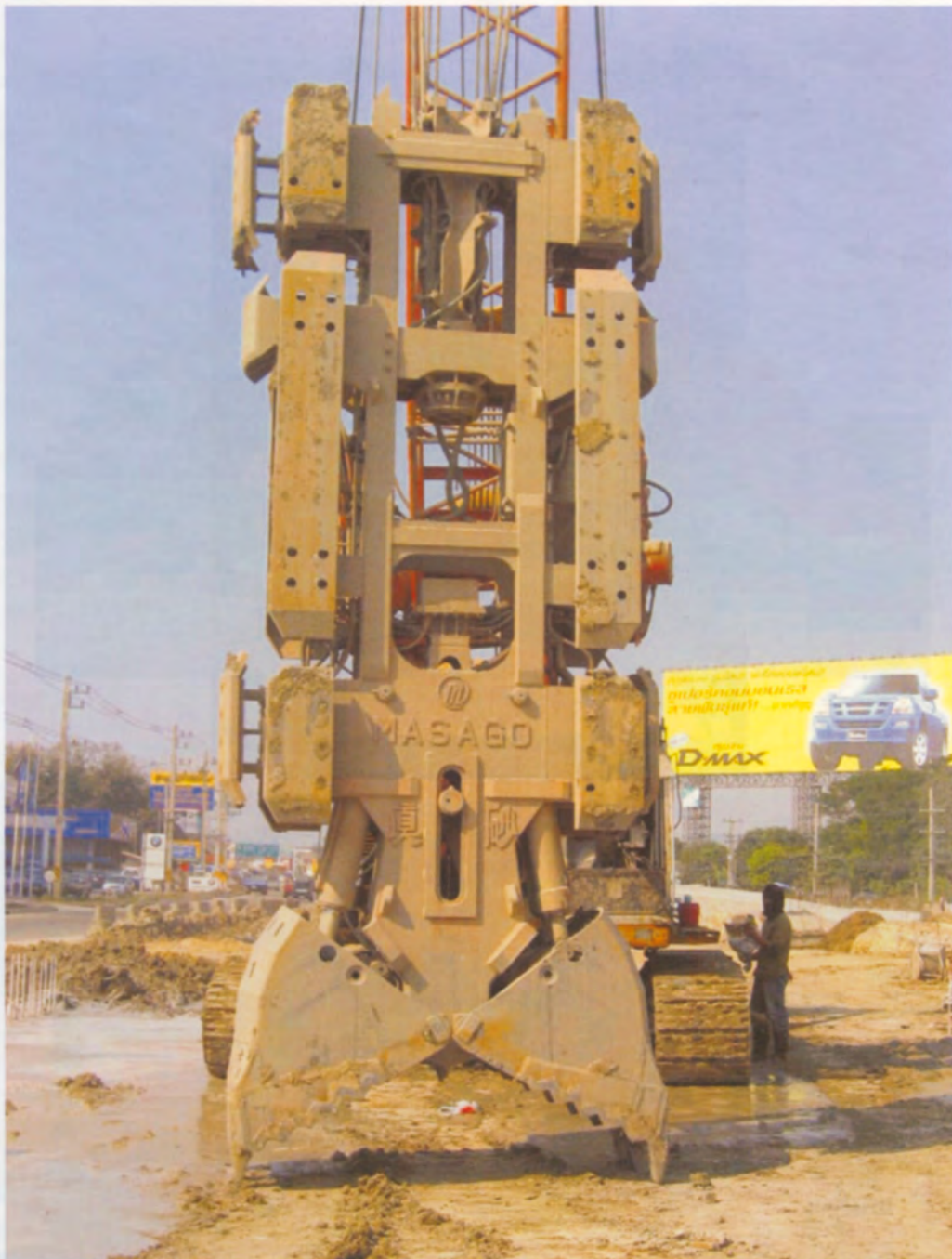
รูปที่ 1 เครื่องจักรขุดดินสำหรับก่อสร้างผนังปิดแบบ Cable hang grab
