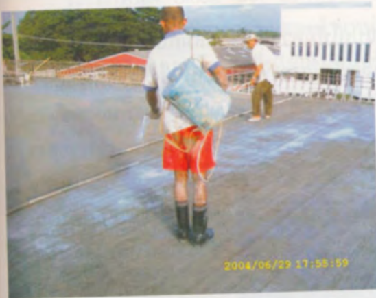
การบ่มคอนกรีต ด้วยน้ำยา
