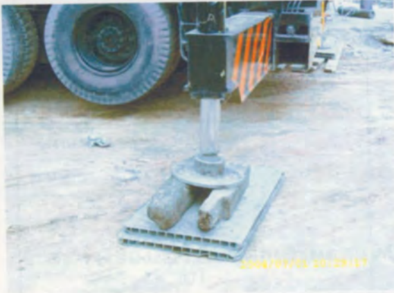
ตรวจสอบฐานรองรับรถยก (Mobile Crane)
