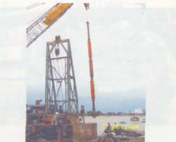
ก้านและหัวเจาะที่ใช้ในการขุดเจาะ โดยวิธี Reverse Circulation
