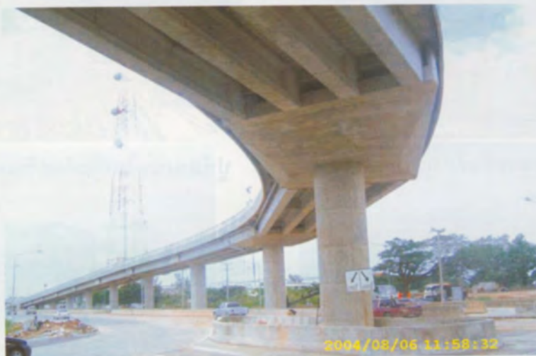
รูปที่ 1 คานหัวเสารูปทรงพื้นยื่น แบบตัน (Solid Type)
