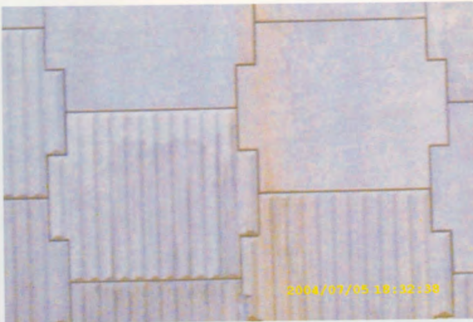
รูปที่ 2 แผ่นผนังคอนกรีตกำพวงกันดิน (Precast Facing Panels) แบบสี่เหลี่ยม
