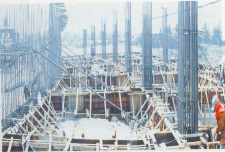
รูปที่ 4 งานก่อสร้างคานคอดิน
