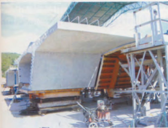
New Segment ย้ายมาอยู่ในตำแหน่ง Match Cast
