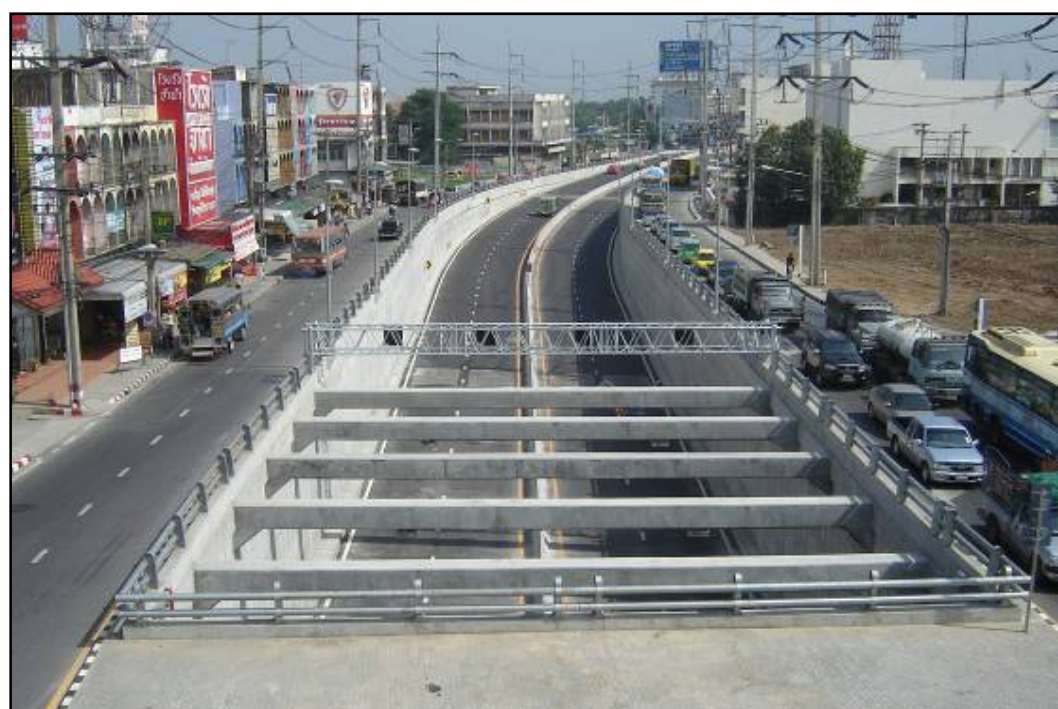
รูปที่ 1-2 ทางลอดทางแยก (Underpass)
