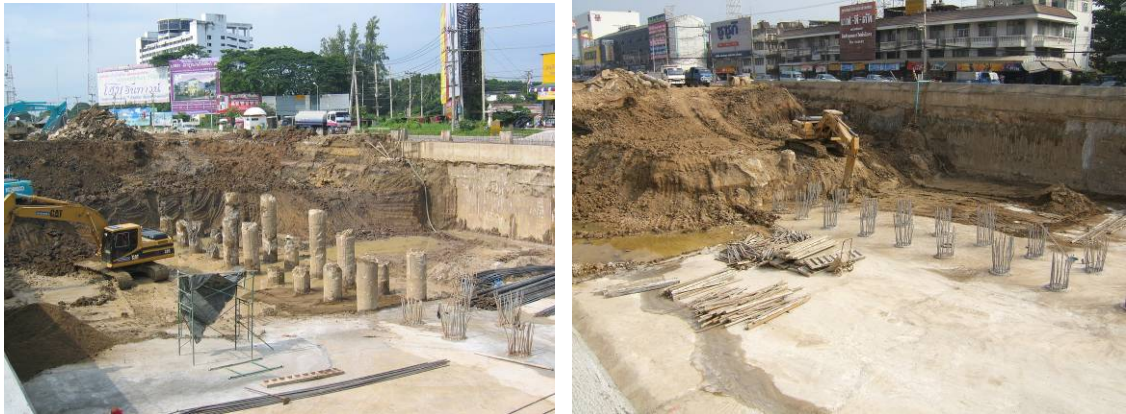
รูปที่ 4-8 ขุดเปิดชั้นดินทีละช่วงและพื้น Lean Concrete เพื่อก่อสร้างส่วนค้ำยันเป็นช่วงๆ
