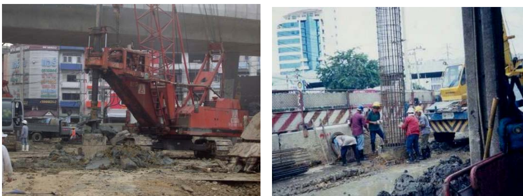
รูปที่ 4-4 เสาเข็มเจาะสำหรับโครงสร้าง Base Slab
