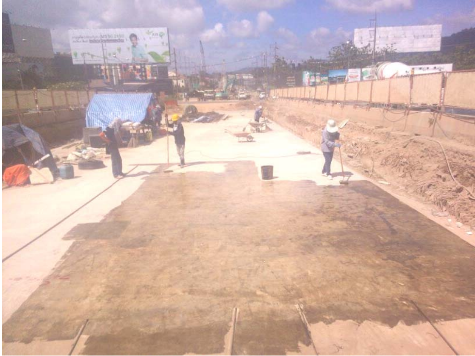
รูปที่ 5-10 เตรียมพื้นที่ก่อสร้างก่อนลงเหล็กเสริมและลวดอัดแรง
