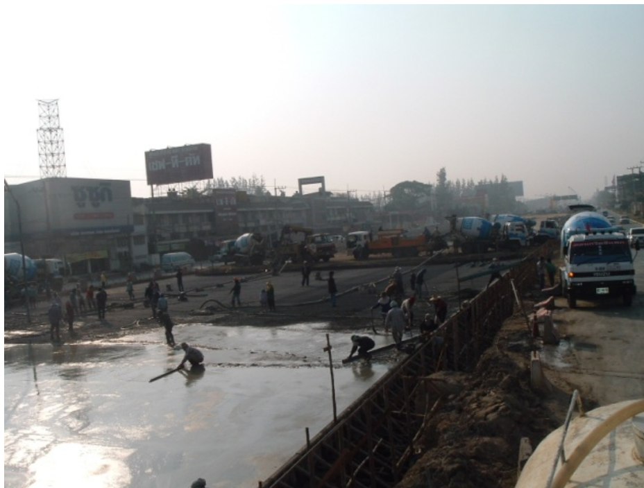
รูปที่ 5-6 แสดงเหล็กเสริมและการเทคอนกรีตพื้นสะพานให้เสร็จในครั้งเดียว
