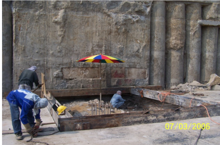
รูปที่ 6-9 งาน DIAPHRAGM WALL ที่จะทำงาน PIPE JACKING เป็นท่อเหล็กกระบายน้ำ เชื่อมต่อกับ ระบบโรงสูบน้ำใต้ดิน (SUMP PUMP TANK) บริเวณมุมสี่แยกเขต-พหล ฝั่งถนนเกษตร-นวมินทร์ขาออก
