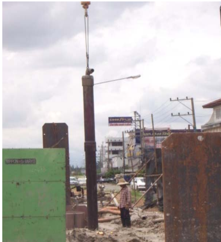
รูปที่ 3-32 ท่อดูดทำความสะอาดกันหลุม
