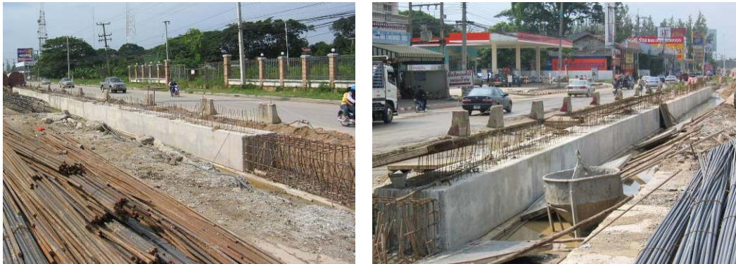
รูปที่ 4-3 คานรัดแนวกำแพง (Cap Beam) ก่อนดำเนินการขุดเปิด
