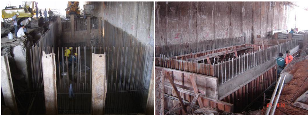
รูปที่ 6-1 การก่อสร้างบ่อพักน้ำด้านใต้พื้นทางลอดในจุดต่ำสุดของทางลอดปากเกร็ด
