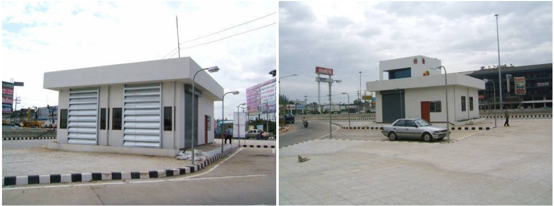
รูปที่ 6-6 อาคารควบคุมเครื่องสูบน้ำ (Control Building)
