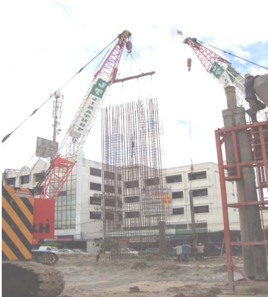
รูปที่ 3-34 การติดตั้งเหล็กเสริมที่เตรียมไว้ลงในหลุมเจาะผนังพีต
