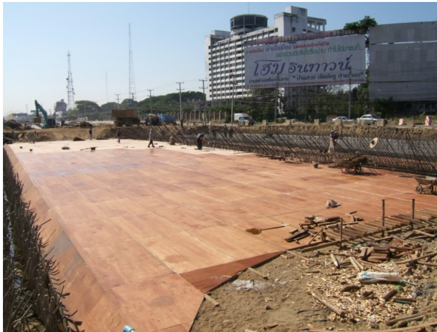
การจัดวางไม้แบบท้องพื้น
