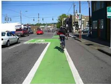
รูปที่ 25 การใช้สีบนพื้นผิวทางจักรยาน
