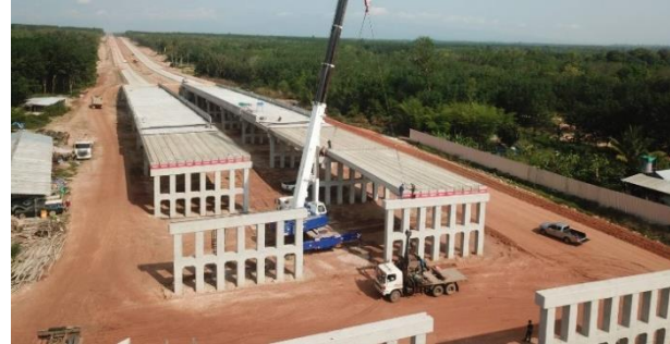
ค. บริเวณที่มีการทำงานในที่สูงบริเวณสะพานข้ามทางแยก
