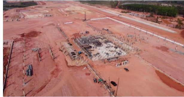
ก. บริเวณงานก่อสร้างอาคารด่านพรมแดน
